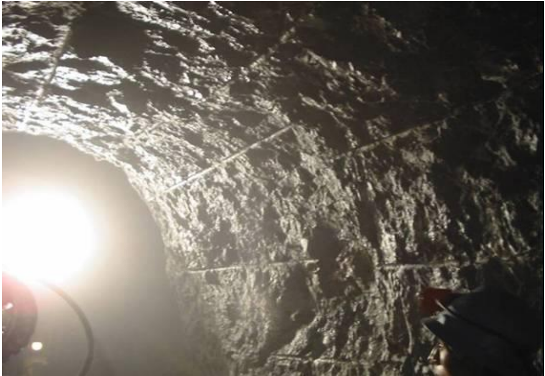
Fotografía N° 2.6: Se puede notar las medias cañas del perfil de la galería
