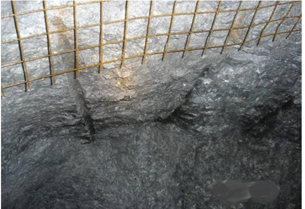
Fotografía N° 2.7: En el techo de la galería se nota las medias cañas
