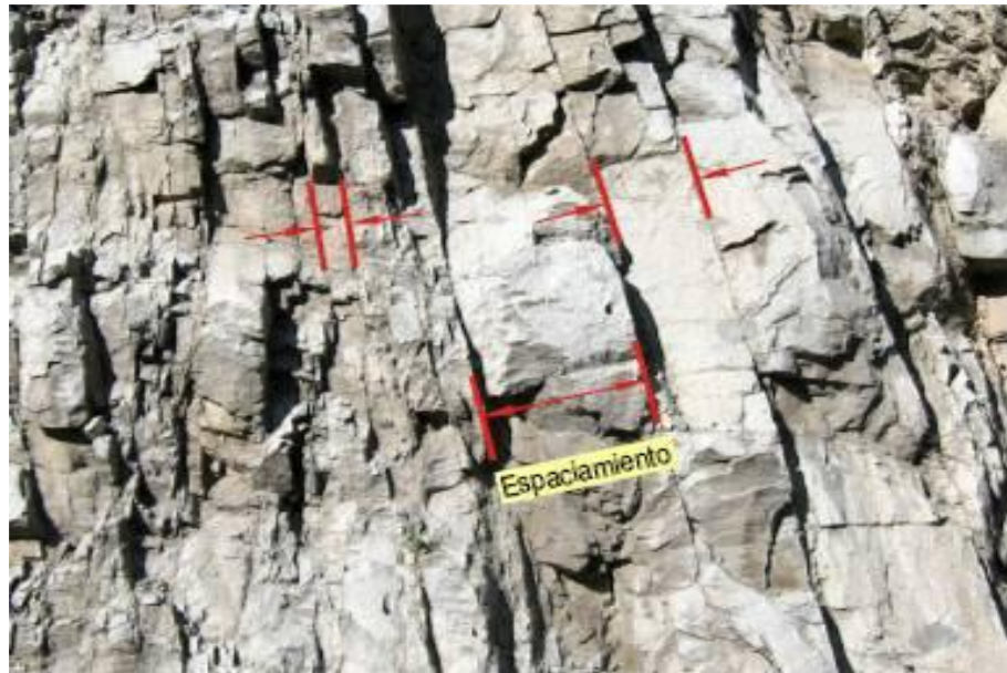
Figura 2 Espaciado de una discontinuidad (Tomado de Manual de Geomecánica Aplicada a la Prevención de Accidentes por Caída de Roca en Minería Subterránea- Sociedad Nacional de Minería Petróleo y Energía)
