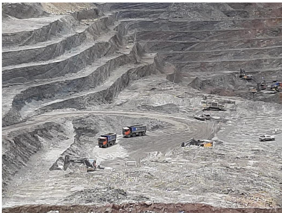
Imagen N° 3 Excavación y carguío de desmonte
