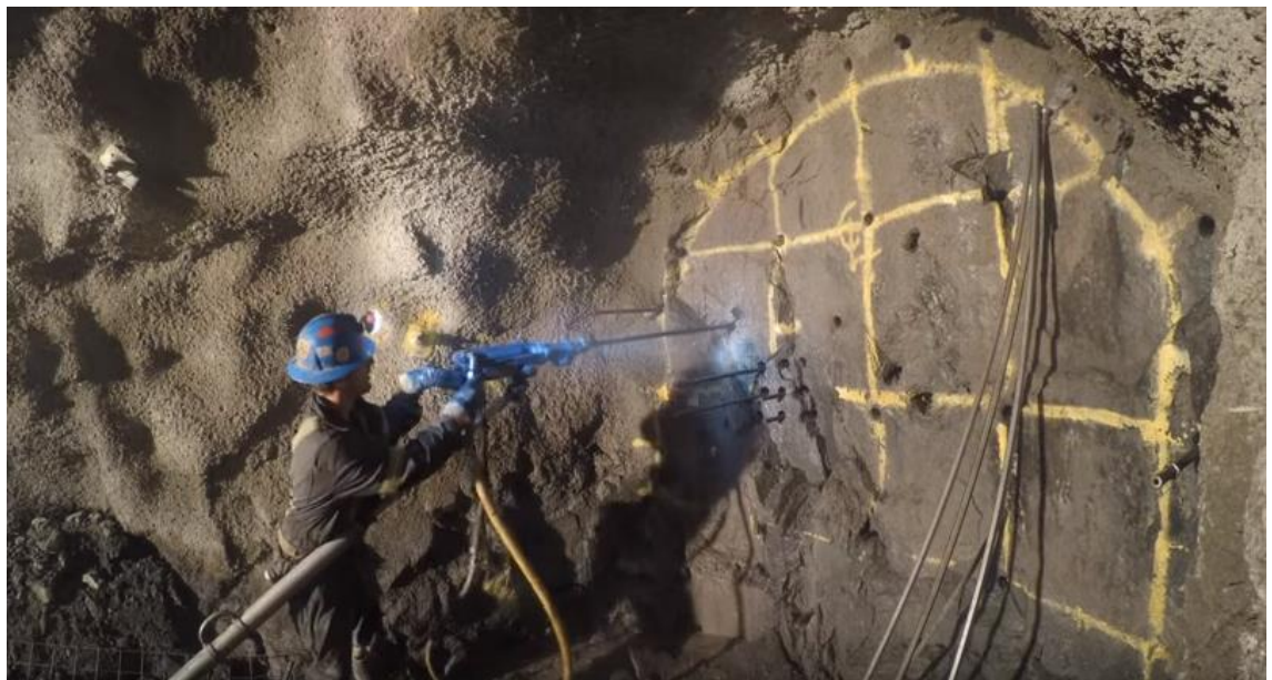
Malla de perforación y posicionamiento de perforadora-Planeamiento Mina Casapalca
