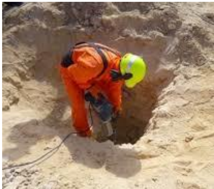
Foto 6. Calicata de exploración
