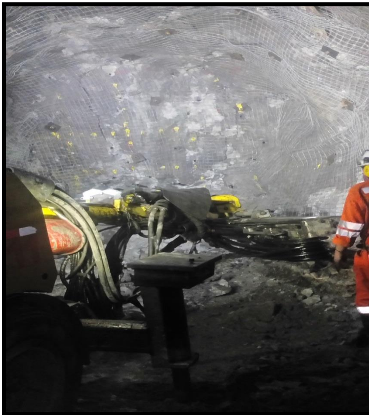
Fotografía N° 2. Perforación de taladros.
