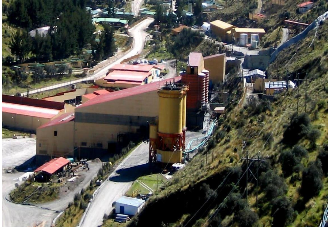
Ilustración 14. Planta de relleno hidráulico.
