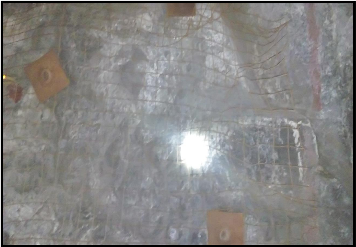
Fotografía N°4. Sostenimiento con pernos.
