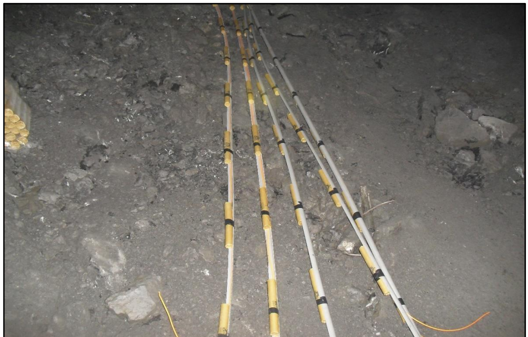
Figura N° 21 Explosivos para Realizar Voladura Controlada en la Corona
