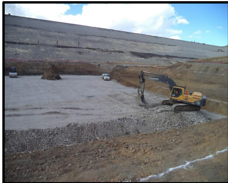
Fotografía 8: Conformación de material over en banqueta cota 4247
