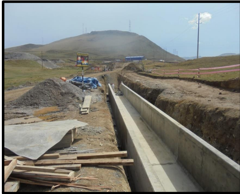
Fotografía 15: Concreto en canal margen izquierdo
