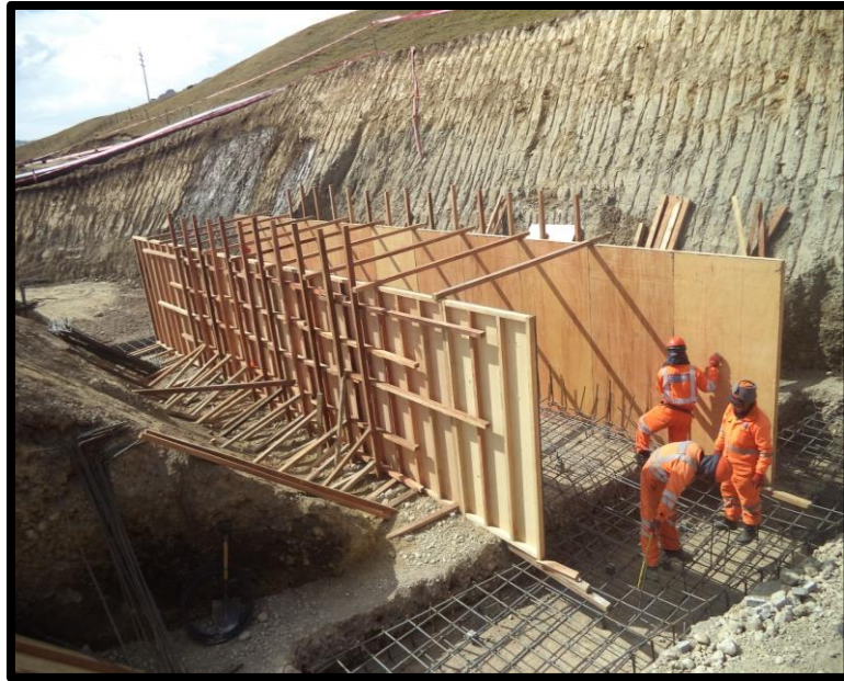
Fotografía 13: Encofrado en canal margen izquierdo
