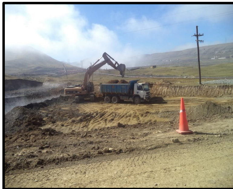
Fotografía 4: Trabajo de excavación en presa de relaves
