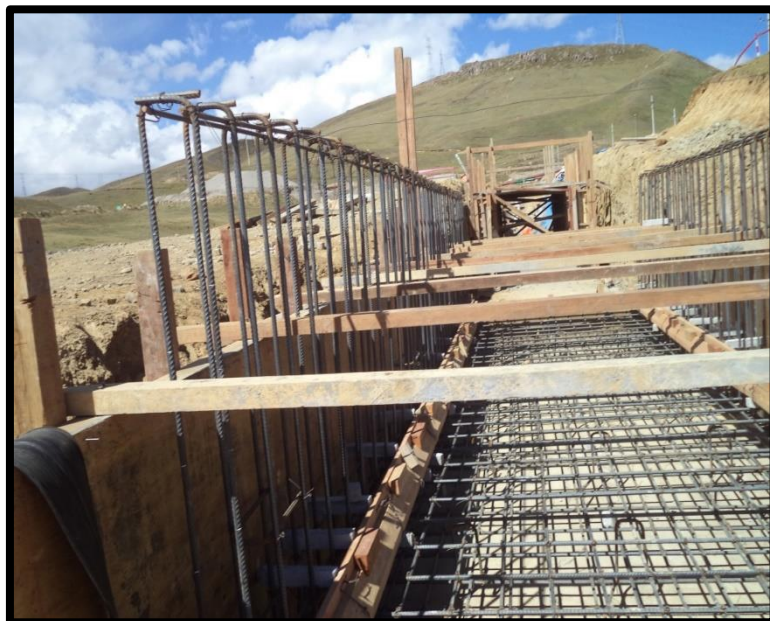
Fotografía 12: Armado de acero corrugado para canal de concreto
