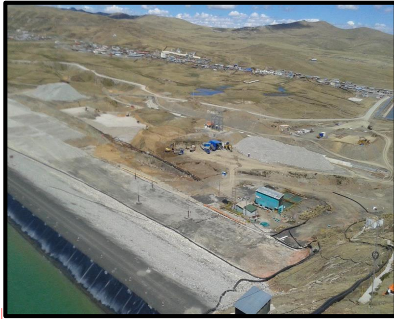
Fotografía 3: Excavación en presa de relaves Banqueta 4250 msnm
