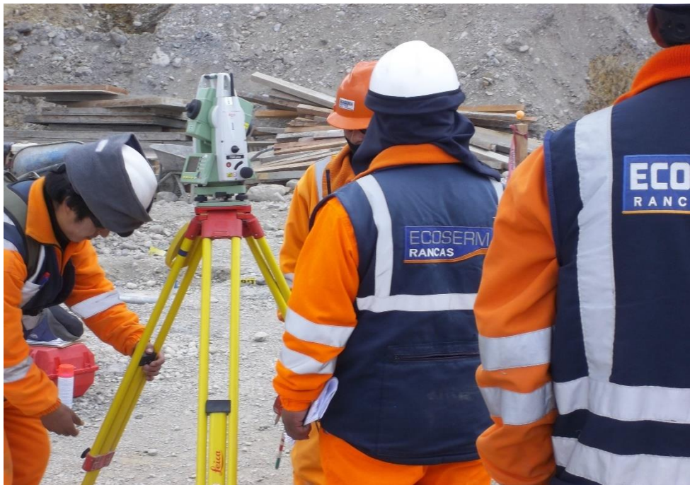
Foto: Control topográfico presa de relaves
