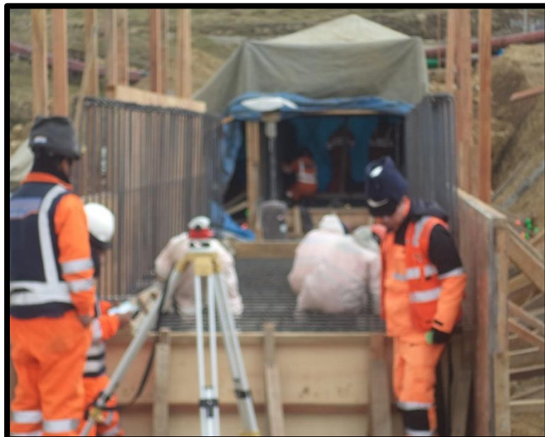
Fotografía 14: Control topográfico de encofrado canal
