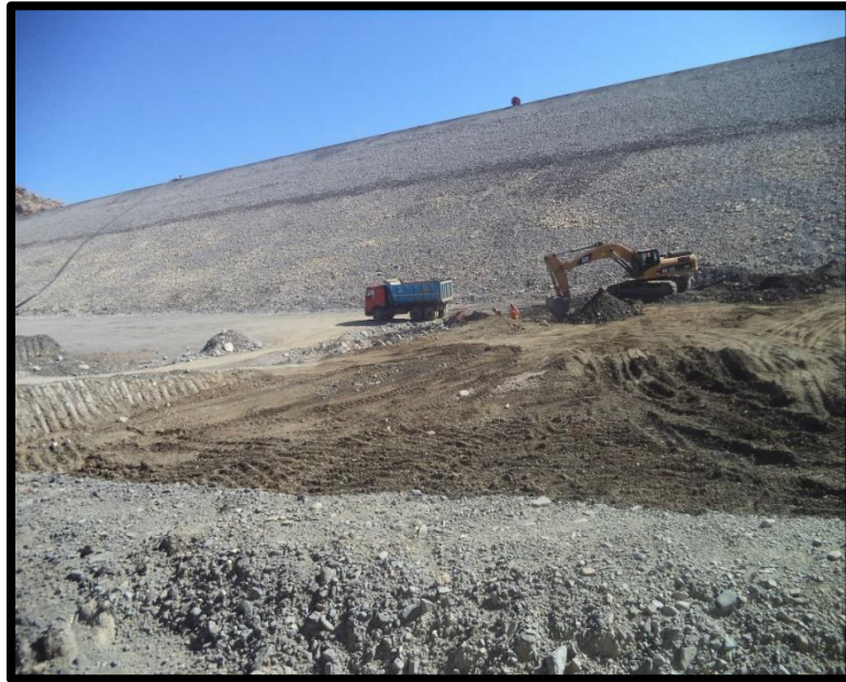
Fotografía 5: Excavación en pie de Dique cota 4266 msnm
