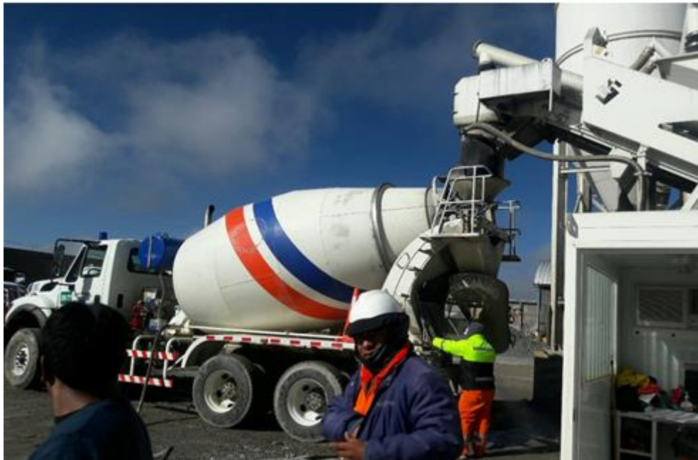
Foto: Verificación de dosificación de planta de concreto
