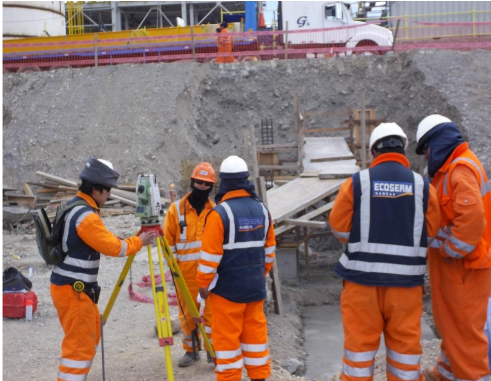
Foto: Control topográfico presa de relaves inspección en campo
