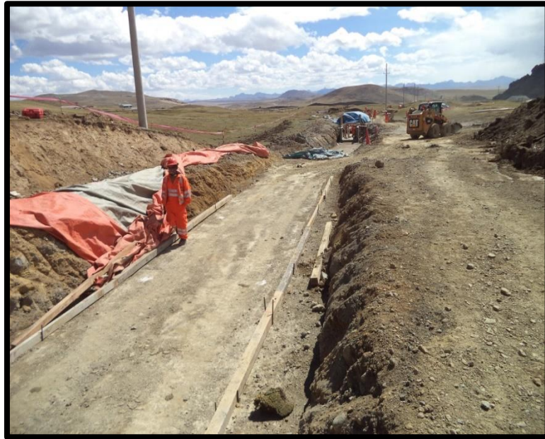
Fotografía 11: Compactación de terreno para canal de concreto
