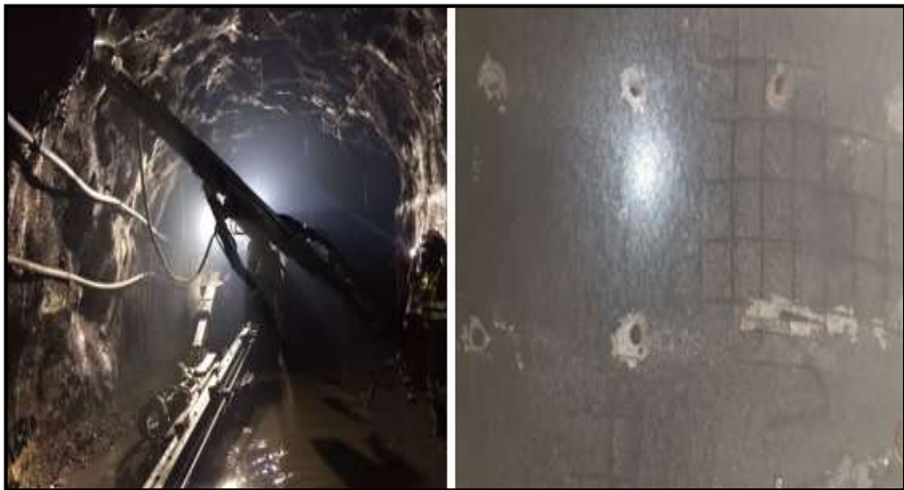
Figura 35. Perforación con Jumbo y distribución de taladros
