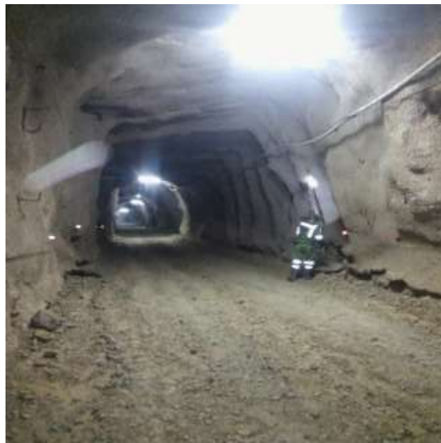
Imagen 2. Punto de verificación de progresiva del túnel 0+450
