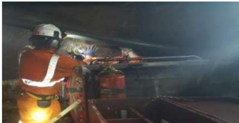
Imagen 4. Pruebas de ensayo de perno de anclaje (Split Set)
