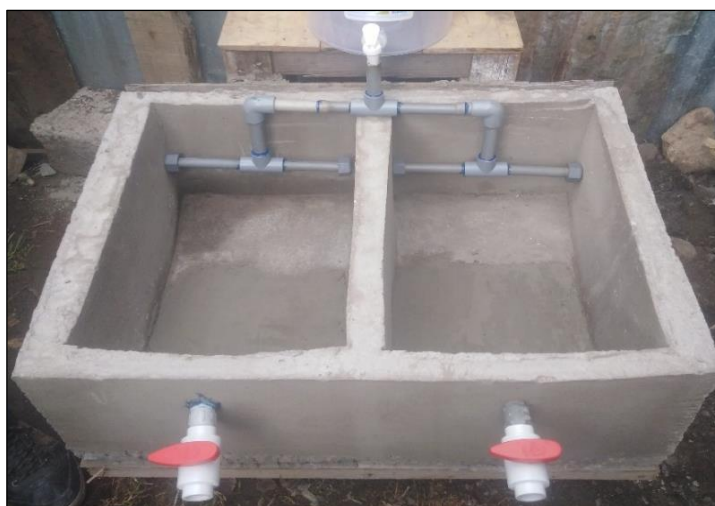
ILUSTRACIÓN° 15. Instalación de sistema de entrada y salida de ambos humedales
