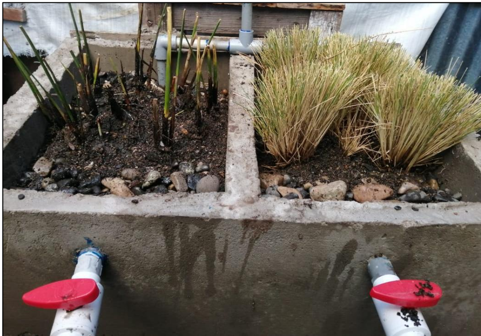
Fotografía N°02: Acondicionamiento de los humedales artificiales
