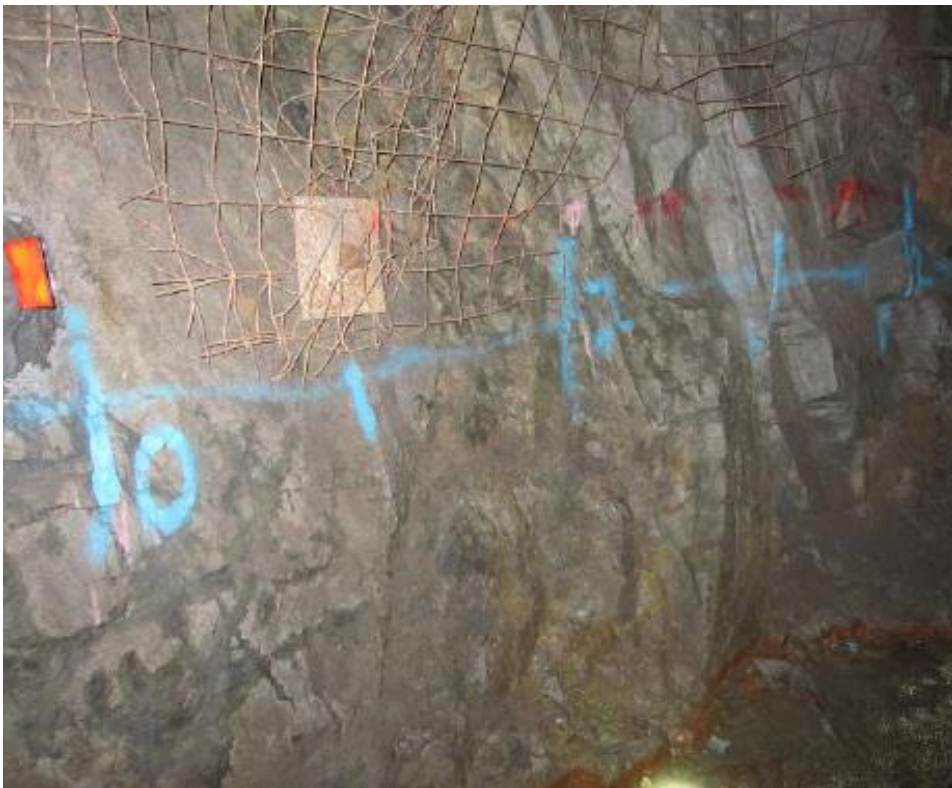
Figura N° 8.- Línea de discontinuidades - veta La Paz 138 Nv 1750
