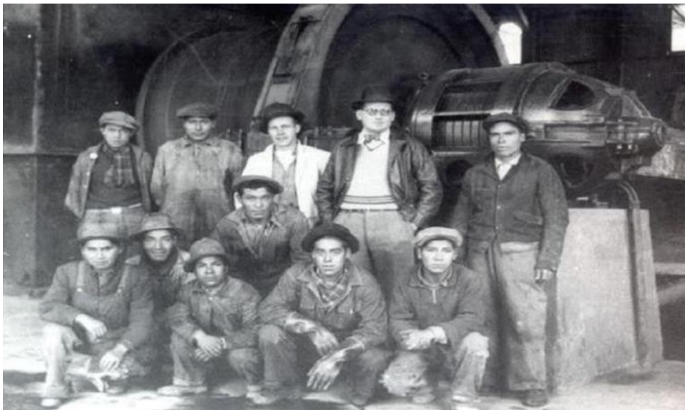
Figura N° 2.- Planta Concentradora de la mina Austria Duvaz
