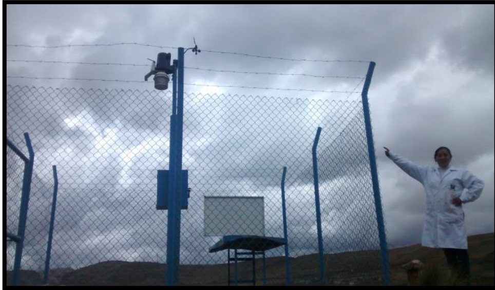
Fotografía N° 02: Vista de la veleta y anemómetro de Activos Mineros- Quiulacocha
