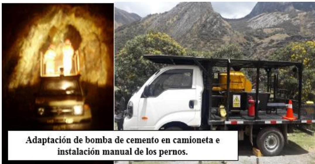
figura N° 26. Adaptación de bomba de cemento en la camioneta
