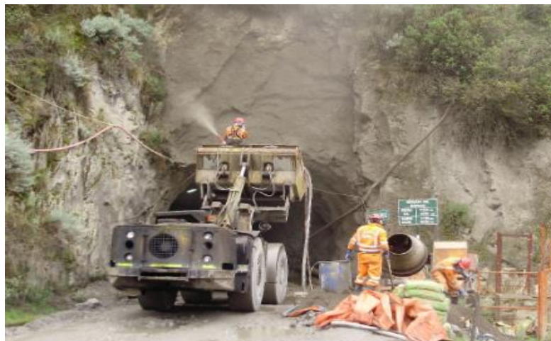
figura N° 29. Sostenimiento con Schotcrete vía húmeda U.E.A. Berlín
