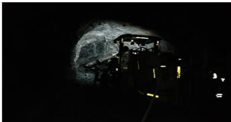
figura N° 22. Equipo para perforación de taladros de sostenimiento
