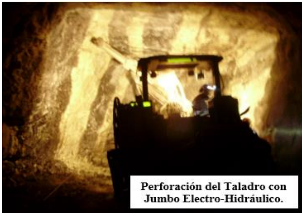
figura N° 25. Perforación con Jumbo Electro Hidráulico
