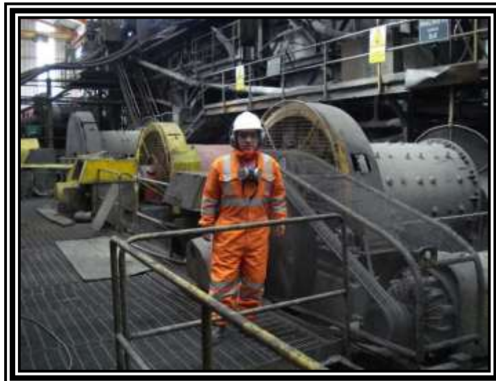
Fotografía 1.7. Sección de Molienda y Remolienda - "San expedito".
