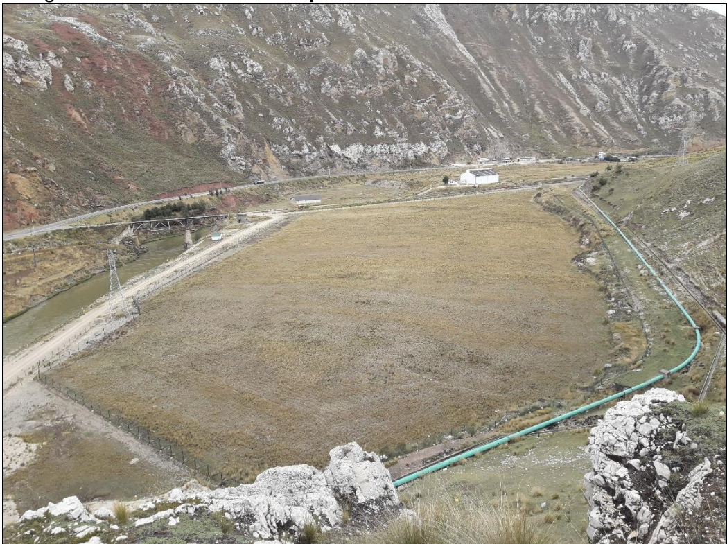
Imagen N° 3: Vista aérea del Depósito de Trióxido de Arsénico Vado.
