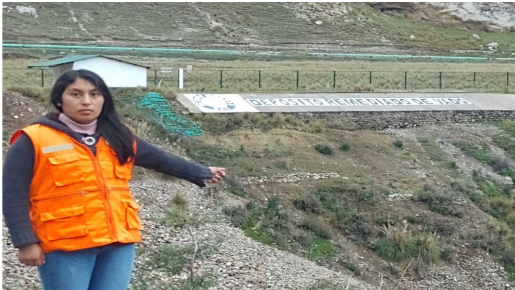
FOTO N° 02: VISTA DE LA REMEDIACIÓN DE VADO
