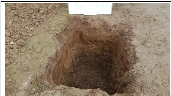
Fotografía N°C-28a: Vista de Calicata C-28 en la progresiva 13+500, profundidad: 1.5 m.
