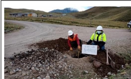
Fotografía N°C-30a: Vista de Calicata C-30 en la progresiva 0+000, profundidad: 1.5 m.
