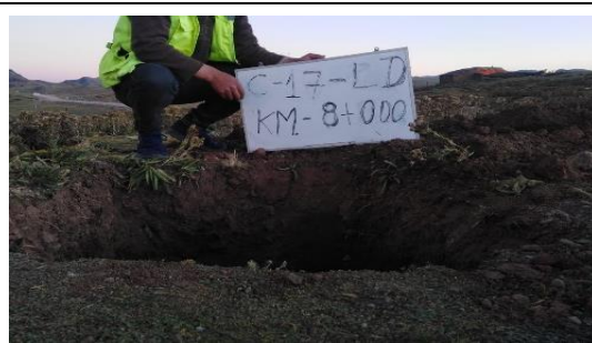
Fotografía N°C-17b: Se observa la Calicata C-17, ubicada al lado derecho de la vía.
