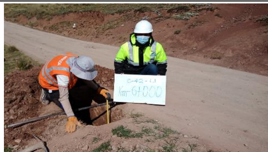
Fotografía N°C-42a: Vista de Calicata C-42 en la progresiva 6+000, profundidad: 1.5 m.
