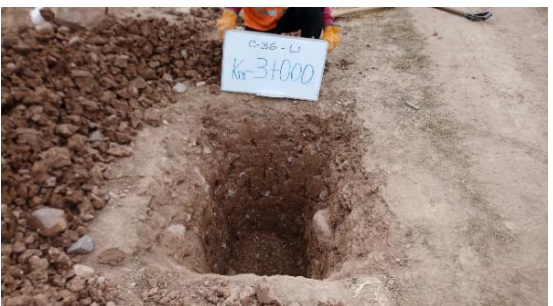
Fotografía N°C-36b: Se observa la Calicata C-36, ubicada al lado izquierdo de la vía.
