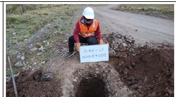
Fotografía N°C-46b: Se observa la Calicata C-46, ubicada al lado izquierdo de la vía.
