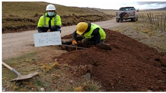
Fotografía N°C-32a: Vista de Calicata C-32 en la progresiva 1+000, profundidad: 1.5 m.
