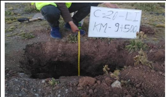
Fotografía N°C-20b: Se observa la Calicata C-20, ubicada al lado izquierdo de la vía.
