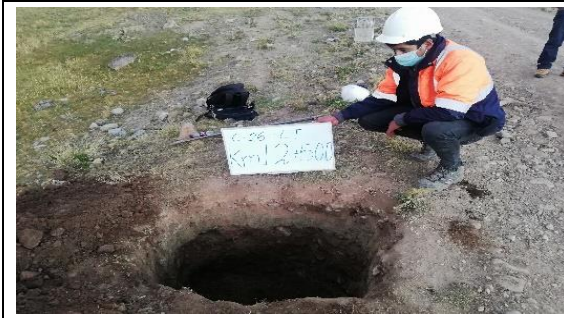
Fotografía N°C-26a: Vista de Calicata C-26 en la progresiva 12+500, profundidad: 1.5 m.
