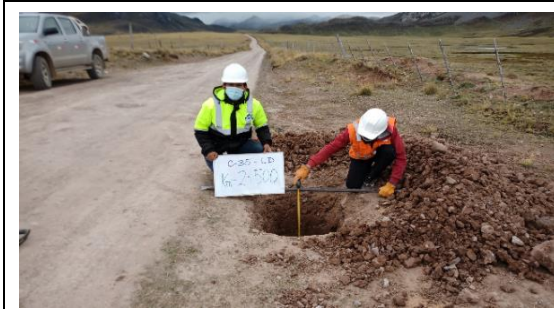
Fotografía N°C-35a: Vista de Calicata C-35 en la progresiva 2+500, profundidad: 1.5 m.
