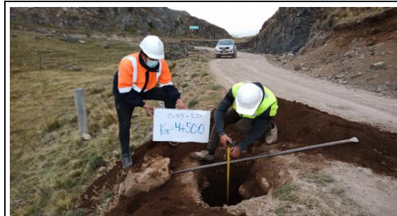
Fotografía N°C-39a: Vista de Calicata C-39 en la progresiva 4+500, profundidad: 1.5 m.
