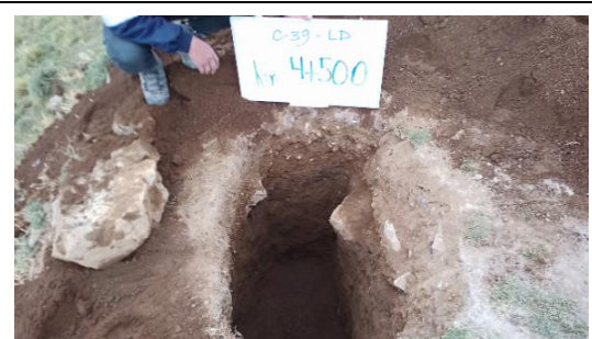
Fotografía N°C-39b: Se observa la Calicata C-39, ubicada al lado derecho de la vía.
