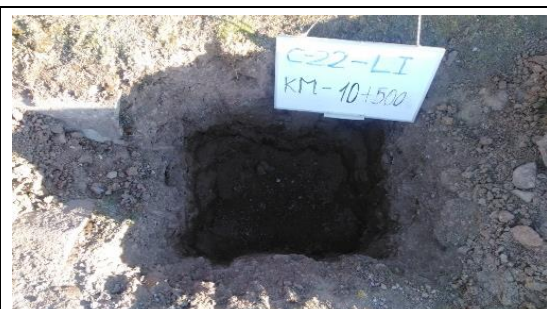
Fotografía N°C-22b: Se observa la Calicata C-22, ubicada al lado izquierdo de la vía.
