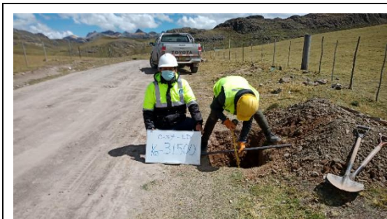
Fotografía N°C-37a: Vista de Calicata C-37 en la progresiva 3+500, profundidad: 0.9 m.
