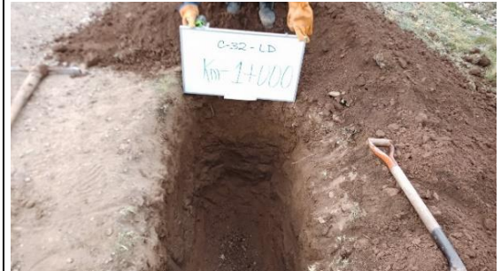
Fotografía N°C-32b: Se observa la Calicata C-32, ubicada al lado derecho de la vía.
