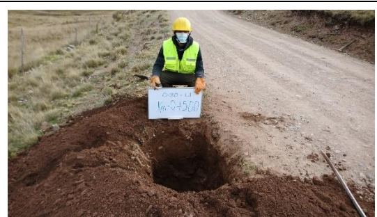
Fotografía N°C-31b: Se observa la Calicata C-31, ubicada al lado izquierdo de la vía.
