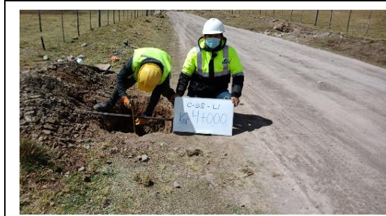
Fotografía N°C-38a: Vista de Calicata C-38 en la progresiva 4+000, profundidad: 1.5 m.
