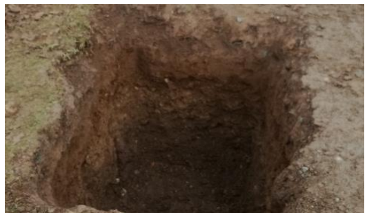
Fotografía N°C-28b: Se observa la Calicata C-28, ubicada al lado izquierdo de la vía.
