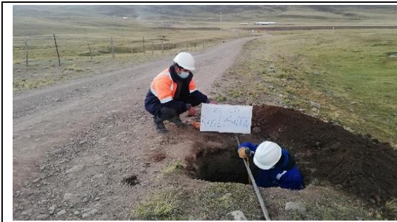
Fotografía N°C-27a: Vista de Calicata C-27 en la progresiva 13+000, profundidad: 1.5 m.
