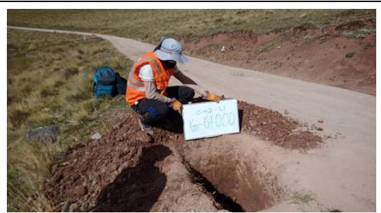
Fotografía N°C-42b: Se observa la Calicata C-42, ubicada al lado izquierdo de la vía.
