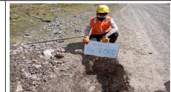
Fotografía N°C-45b: Se observa la Calicata C-41, ubicada al lado izquierdo de la vía, encontrando roca a la profundidad de 0.5 m.
