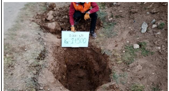
Fotografía N°C-33b: Se observa la Calicata C-33, ubicada al lado derecho de la vía.
