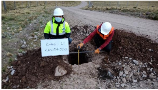
Fotografía N°C-47a: Vista de Calicata C-47 en la progresiva 8+185.62, profundidad: 1.5 m.
