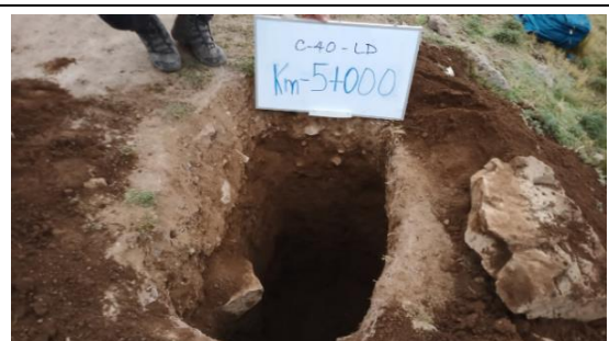
Fotografía N°C-40b: Se observa la Calicata C-40, ubicada al lado derecho de la vía.
