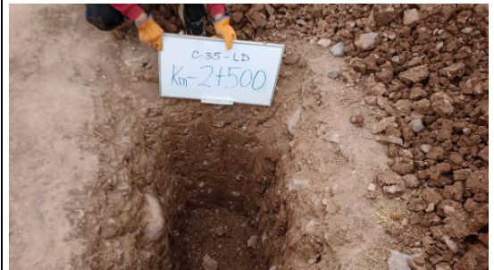
Fotografía N°C-35b: Se observa la Calicata C-35, ubicada al lado derecho de la vía.
