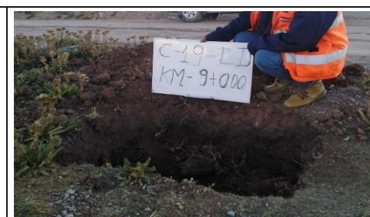
Fotografía N°C-19b: Se observa la Calicata C-19, ubicada al lado izquierdo de la vía.
