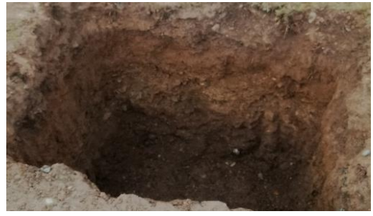
Fotografía N°C-29b: Se observa la Calicata C-29, ubicada al lado derecho de la vía.
