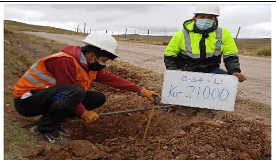
Fotografía N°C-34a: Vista de Calicata C-34 en la progresiva 2+000, profundidad: 1.5 m.
