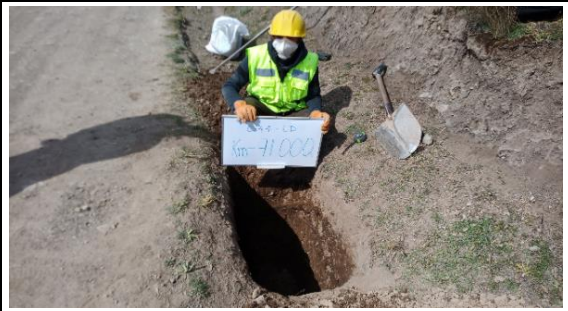
Fotografía N°C-43b: Se observa la Calicata C-43, ubicada al lado derecho de la vía.
