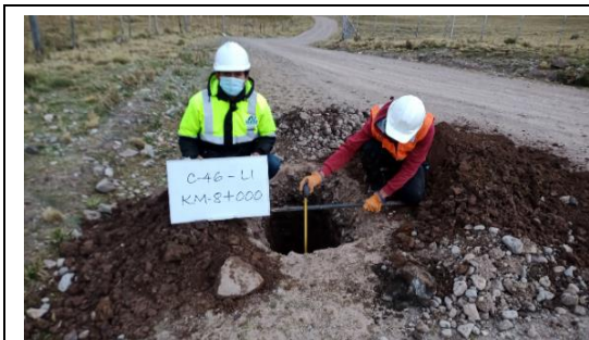
Fotografía N°C-46a: Vista de Calicata C-46 en la progresiva 8+000, profundidad: 1.5 m.
