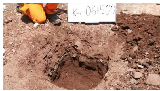
Fotografía N°C-14a: Vista de Calicata C-14 en la progresiva 6+500, profundidad: 1.5 m.
