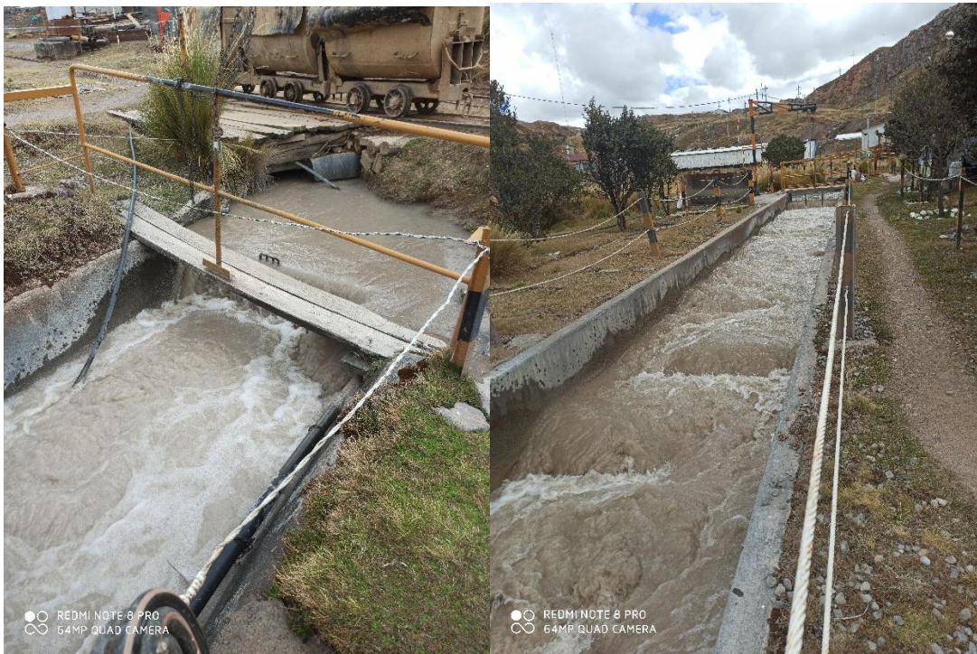
Fotografía 1. Canal de ingreso de agua de mina hacia la Planta de Tratamiento
