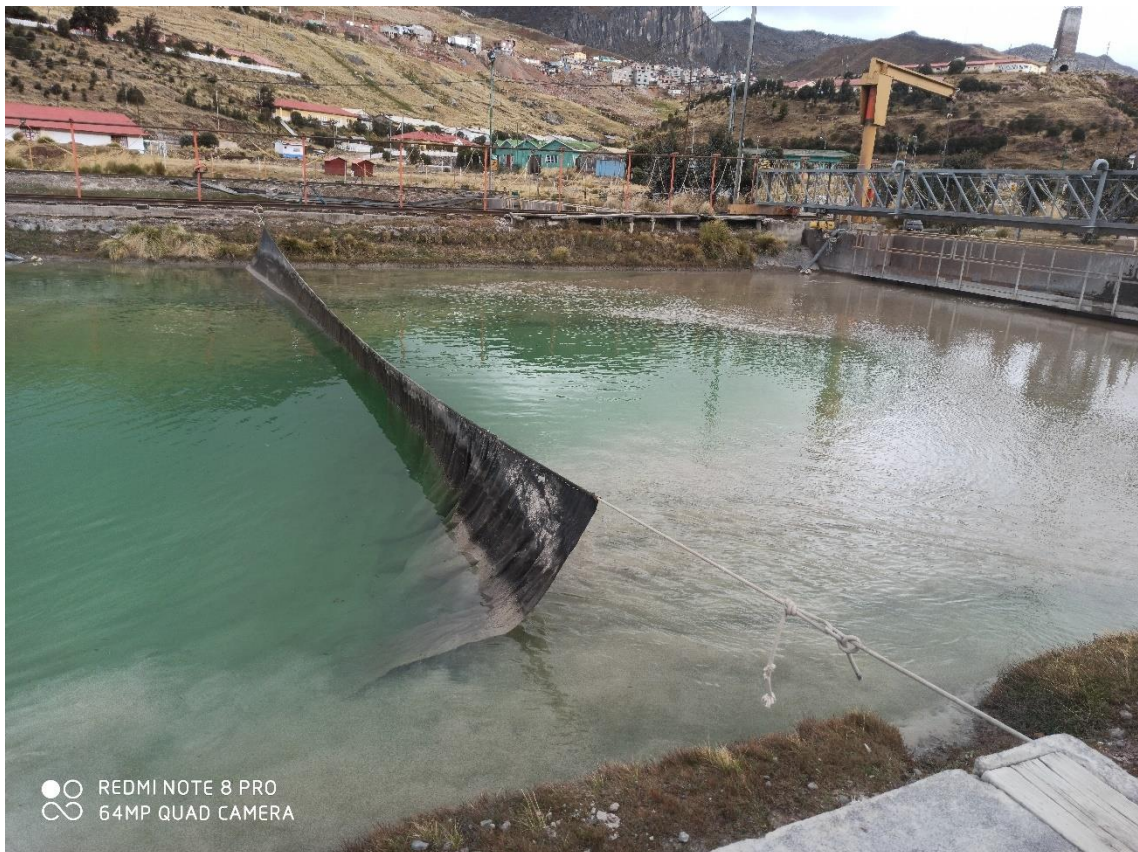
Fotografía 2. Ingreso de agua a la poza de tratamiento
