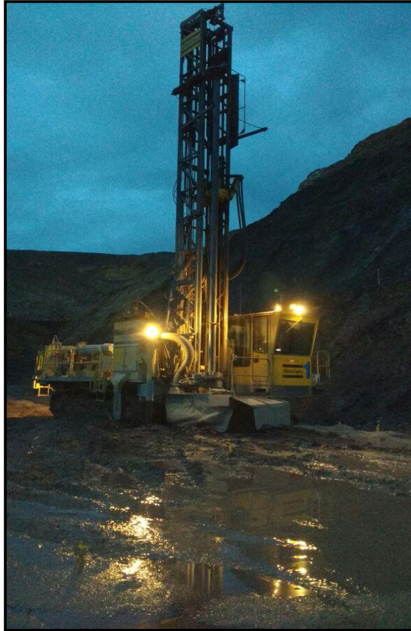
Figura 08. Perforadora en operaciones.
