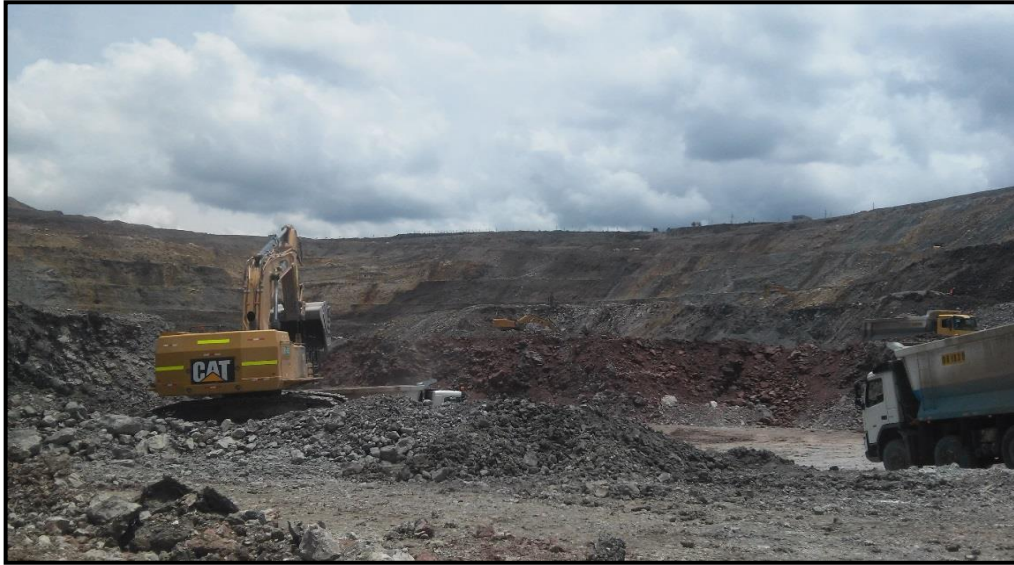
Figura 09. Excavadora en operaciones.
