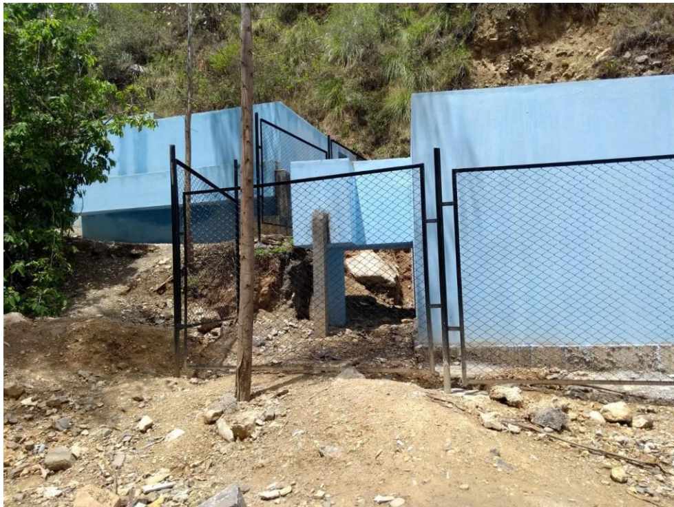
Foto 7 Estación de tratamiento de Agua
