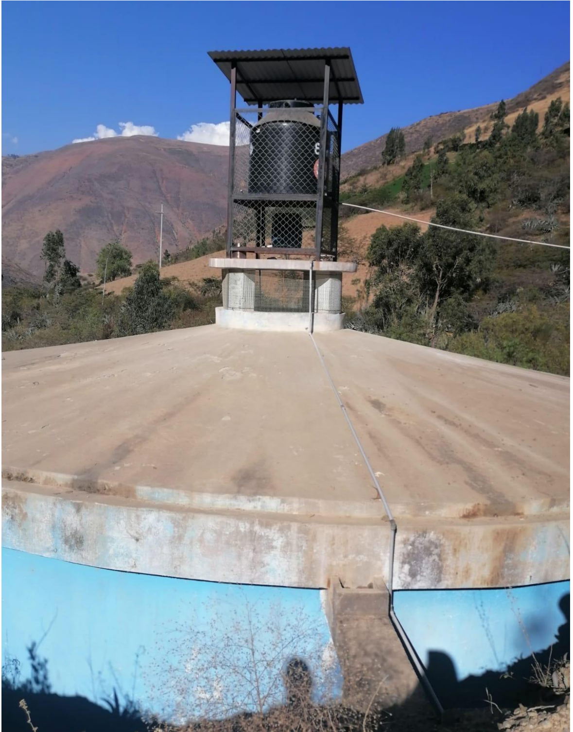
Foto 2 Reservorio y su tanque de cloración
