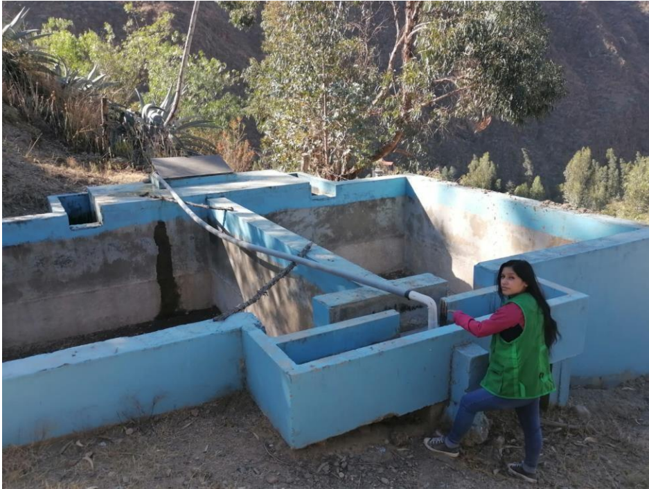
Foto 4 Canal de precipitación del agua
