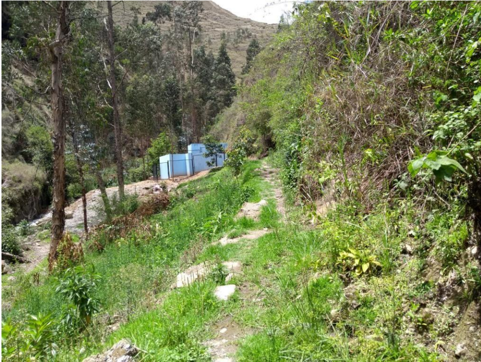
Foto 6 Punto de Pretratamiento de agua canalizada
