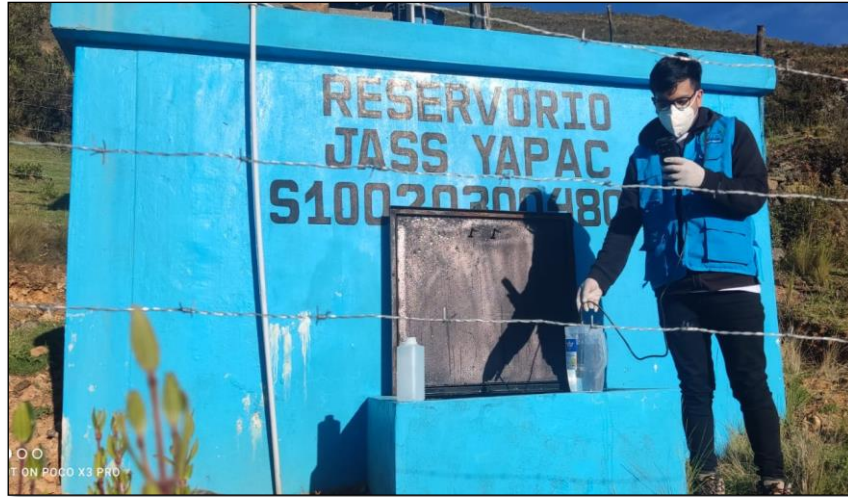
Ilustración 11: Monitoreo de parámetro de cloro residual libre en C.P de Yapac.
