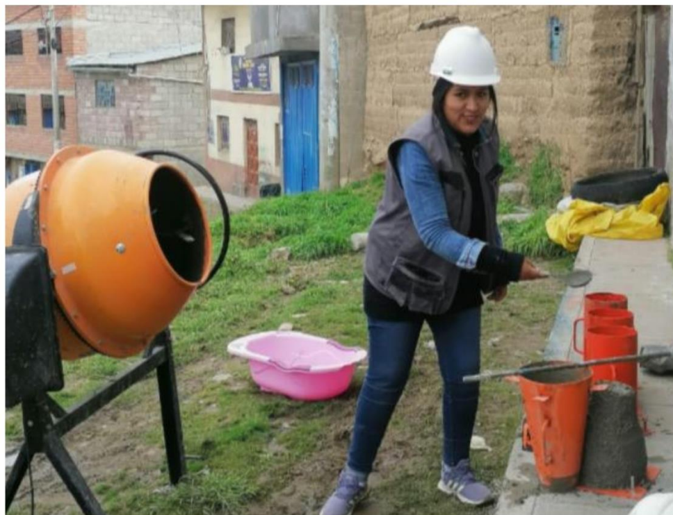
Fotografía 08: Retiro de muestras de concreto base en las probetas para hacer los ensayos necesarios.
