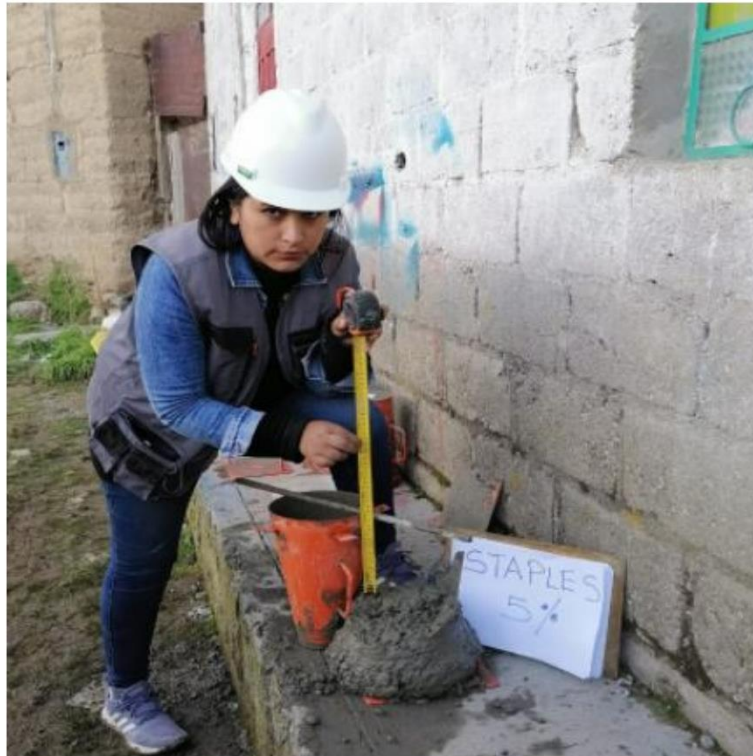
Fotografía 15: Slump del concreto f_c=210\text{kg/cm}^2 con la incorporación de staples de 5%
