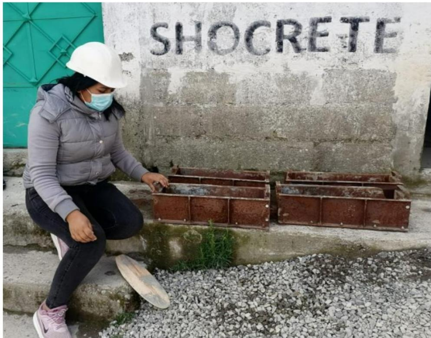
Fotografía 17: Moldes para el acoplo del concreto a realizarse
