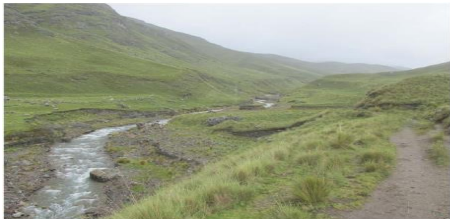
Figura 11. Vista desde aguas abajo en el lecho de la Quebrada Ucuscancha en el Sector del Vaso de Presa. En primer plano los depósitos de suelos aluviales (Q-al) en el lecho, en los bordes de la orilla en la margen derecha afloramientos de calizas y margas de la Formación Chambará (Trs-ch) y en las laderas gruesos depósitos de suelos fluvioglaciarios (Q-fg).
