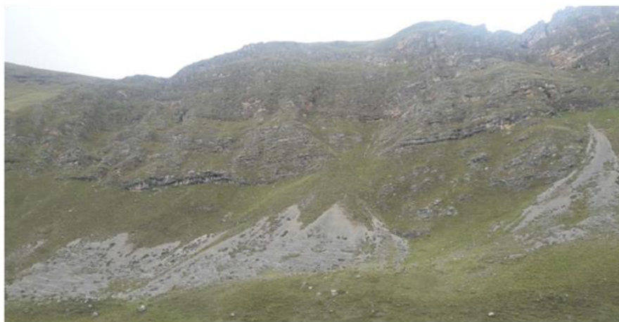
Figura 7. Vista de la margen derecha de Eje de Presa en la Quebrada Ucuscancha. En la parte alta de las laderas, sedimentario de la Formación Chambará (Trs-ch)
