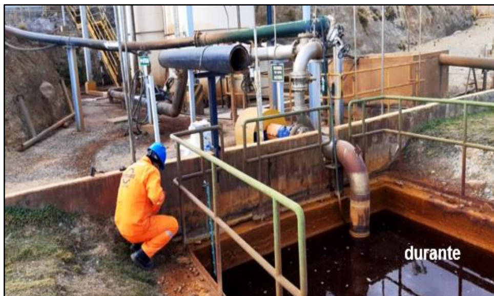
Figura N° 66: Instalación de la regleta para medir el nivel de agua ácida en el canal de succión de agua ácida. (durante)
