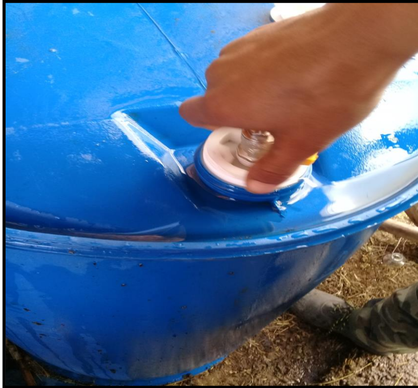
Imagen N° 2: Instalación de Válvula para Abastecimiento de Gas.
