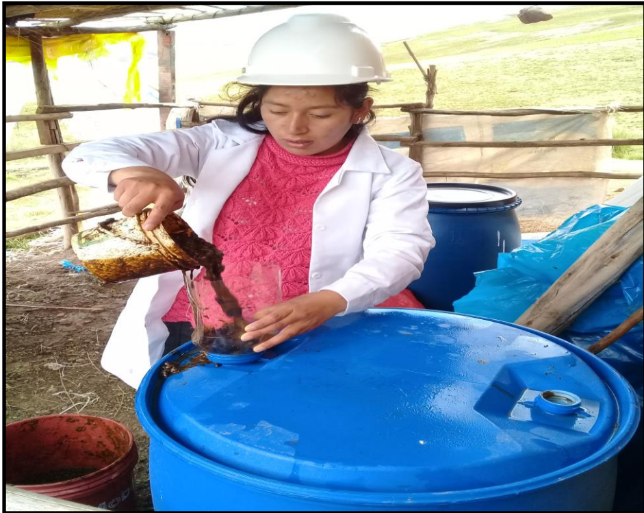
Imagen N° 10: Adición de Sustrato de Estiércol con Agua al Biodigestor
