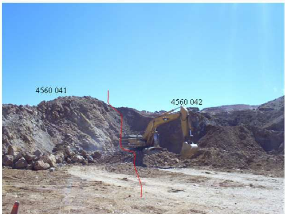
Figura 25. Vista de los Bco. 4560 041 y Bco. 4560 042
