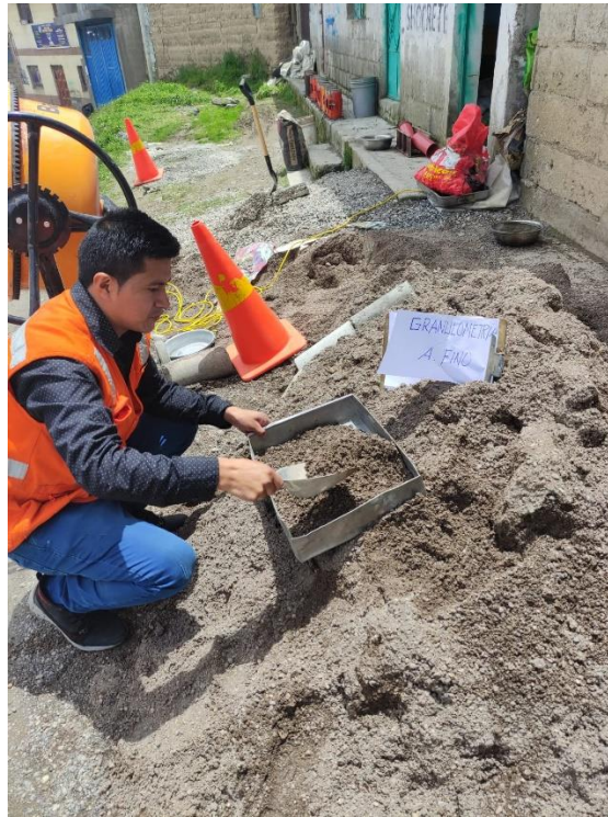
Foto N° 1: Toma de muestras de agregado fino para realizar la caracterización.
