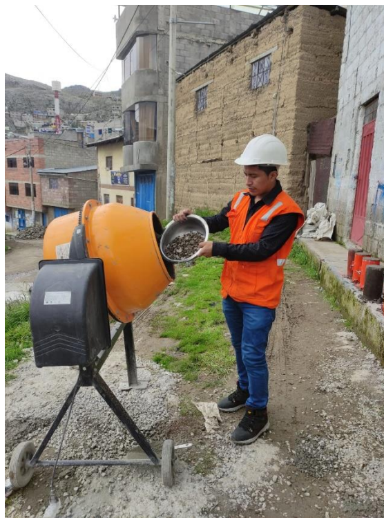
Foto N° 4: Realizando la preparación de la mezcla de acuerdo a los cálculos realizados.
