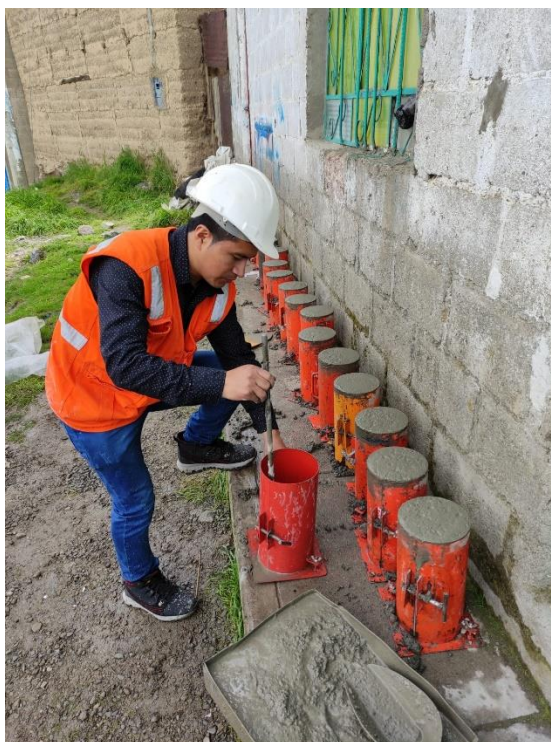
Foto N° 5: Realizando el llenado de las probetas en los cilindros de 15cmx30cm.
