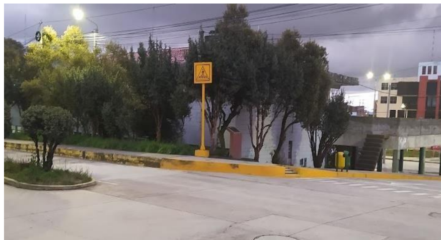
Figura 27. Estado de señal vertical en la intersección entre Av. Los Incas y Calle Janampa
