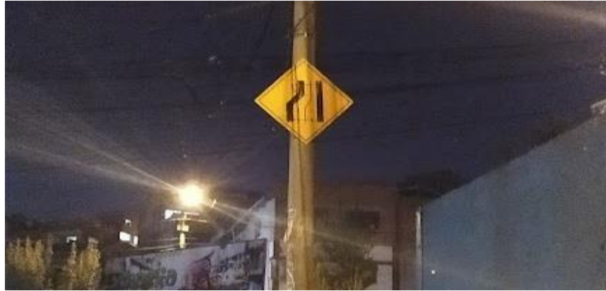
Figura 26. Estado de señal vertical en la intersección entre Av. La Cultura y Av. Daniel Alcides Carrión.
