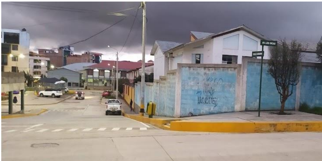
Figura 30. Estado de señal vertical informativa en la Av. Los Incas Calle Janampa.
