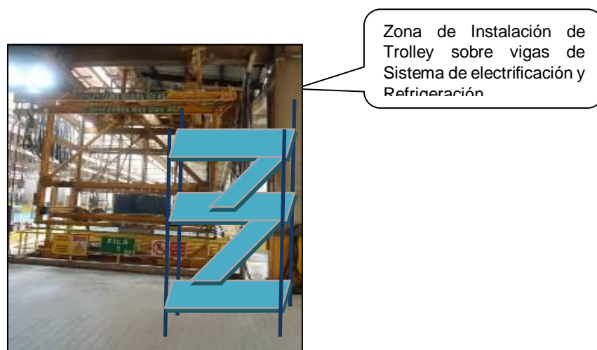
Figura 5: Instalación del Trolley
