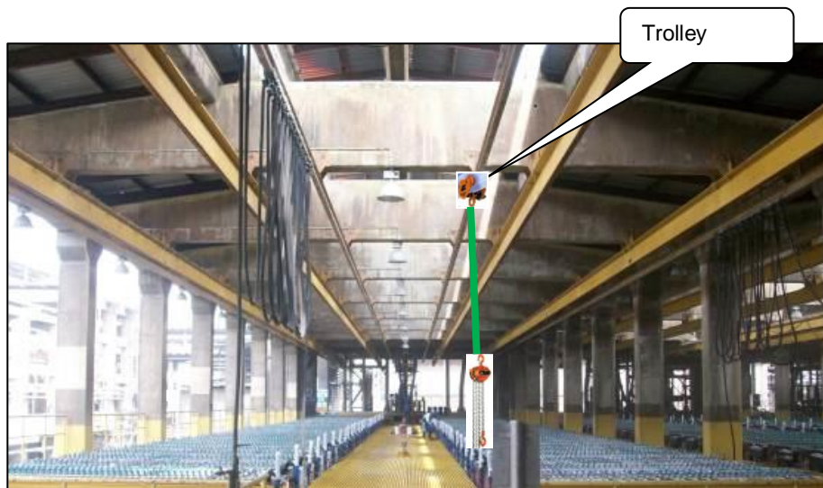
Figura 6: Vista de la instalación de vigas
