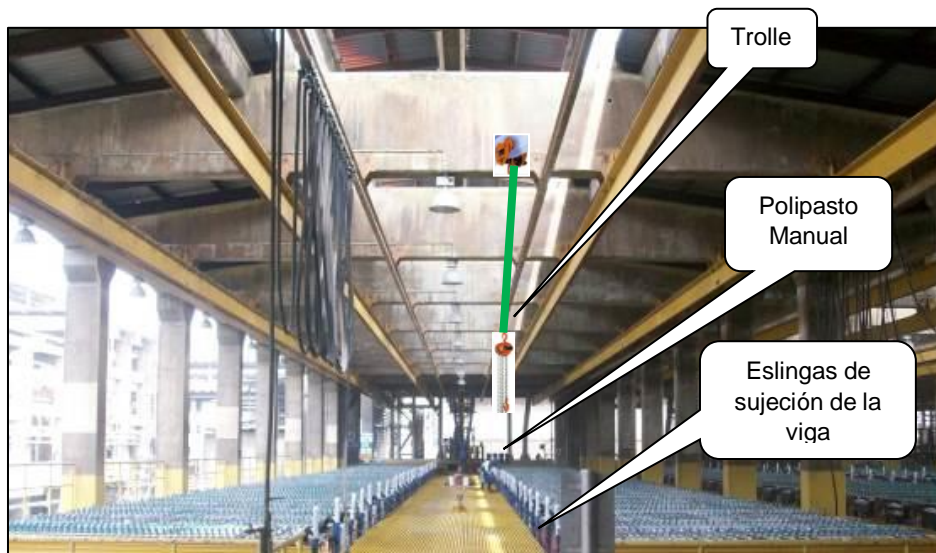
Figura 7: Instalación del trolley para el izaje
