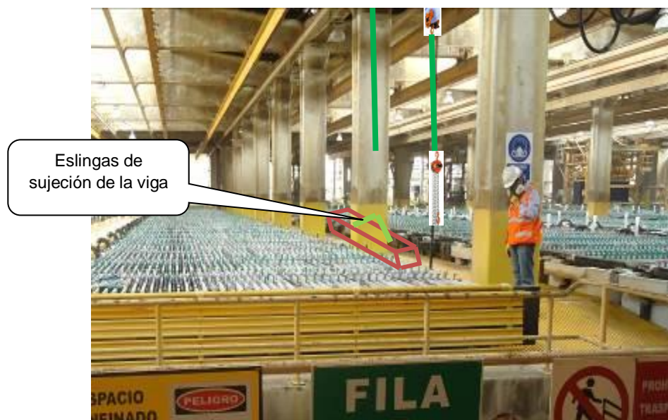
Figura 9: Colocación de eslingas de sujeción a la viga
