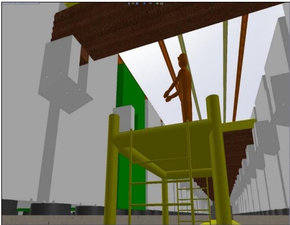
Figura 2: Instalación de puentes para el retiro de la parrilla
