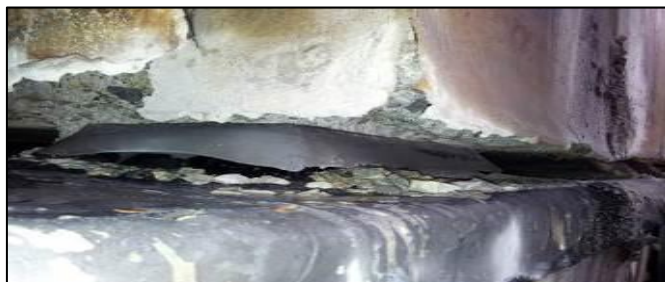
Figura 34: Limpieza de Apoyos de Celdas
