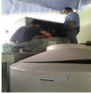
FOTO 26: Instalación de Chiller
