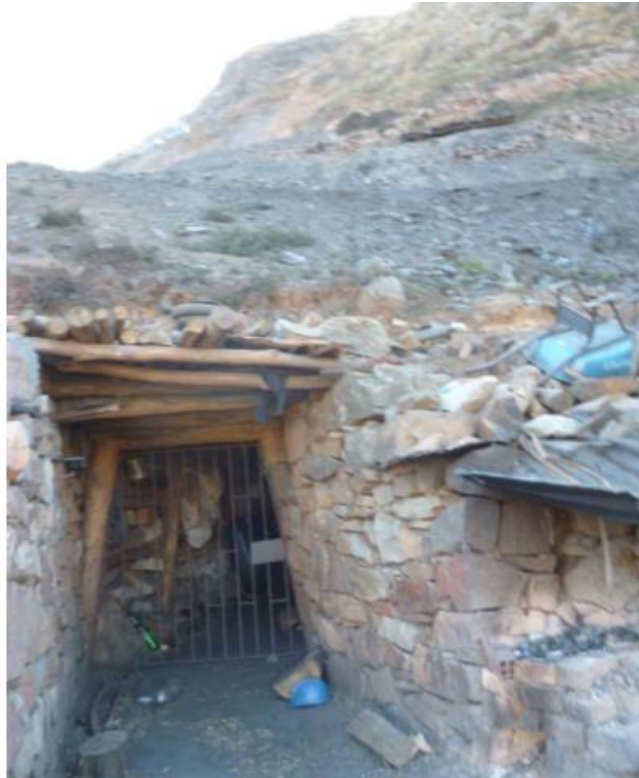
Figura N° 22. Labores con seguridad que no permiten el acceso
