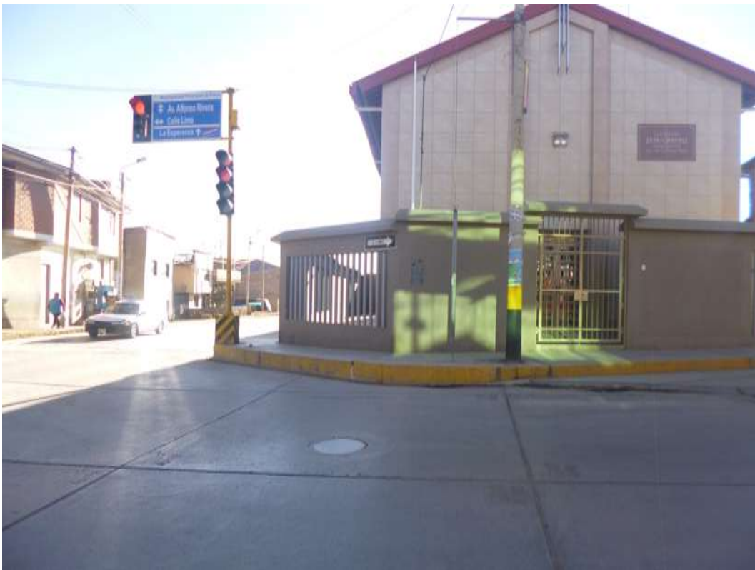
Foto 9 Falta de rampa para discapacitados y cruce de cebra en calle Lima.
