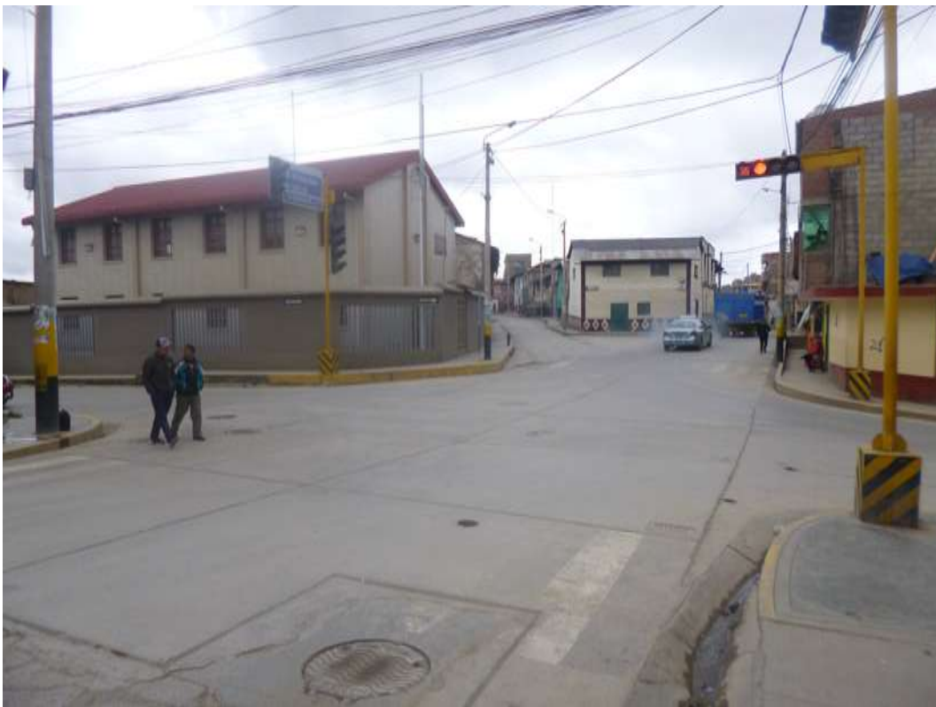
Foto 13 Evidencia que la intersección necesita de un mantenimiento en las marcas de pavimento.
