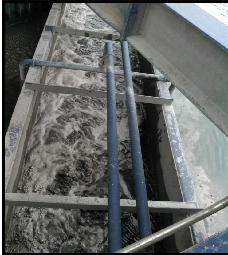
Foto 9. Mezcla de relave y floculante en el feed well
