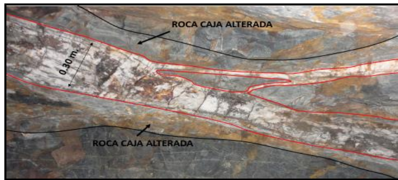
Foto 4. Veta don Gregorio I, Veta de cuarzo masivo bifurcado con parches de pirita, donde altera la roca caja de 0.10 a 0.30 metros dependiendo de la roca caja. Fuente propia.
