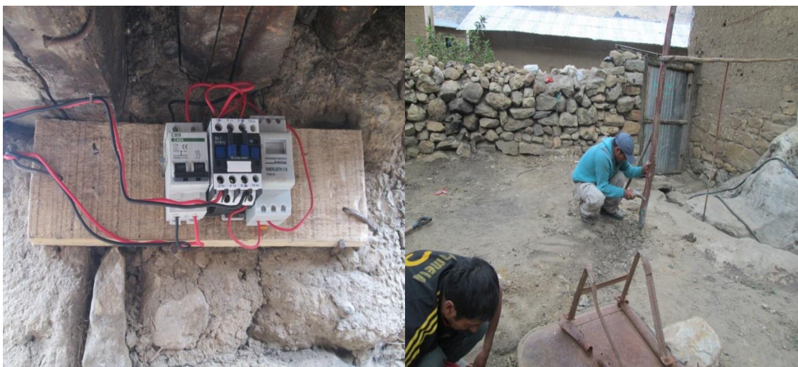
Anexo 35. Instalación del timer y fluido eléctrico
