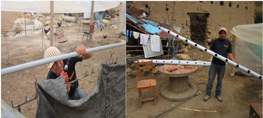
Anexo 40. Conectando los tubos de distribución al tubo de cultivo
