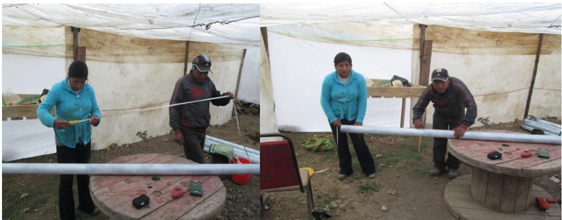
Anexo 32. Medir las distancias de planta a planta y marcado de las distancias
