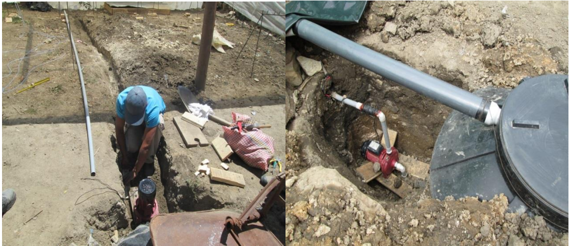
Anexo 37 Instalación del tubo de distribución
