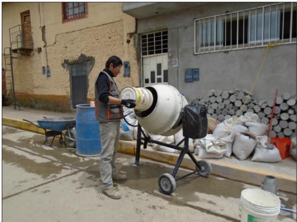
Figura N° 20. Inicio de la elaboración del concreto
