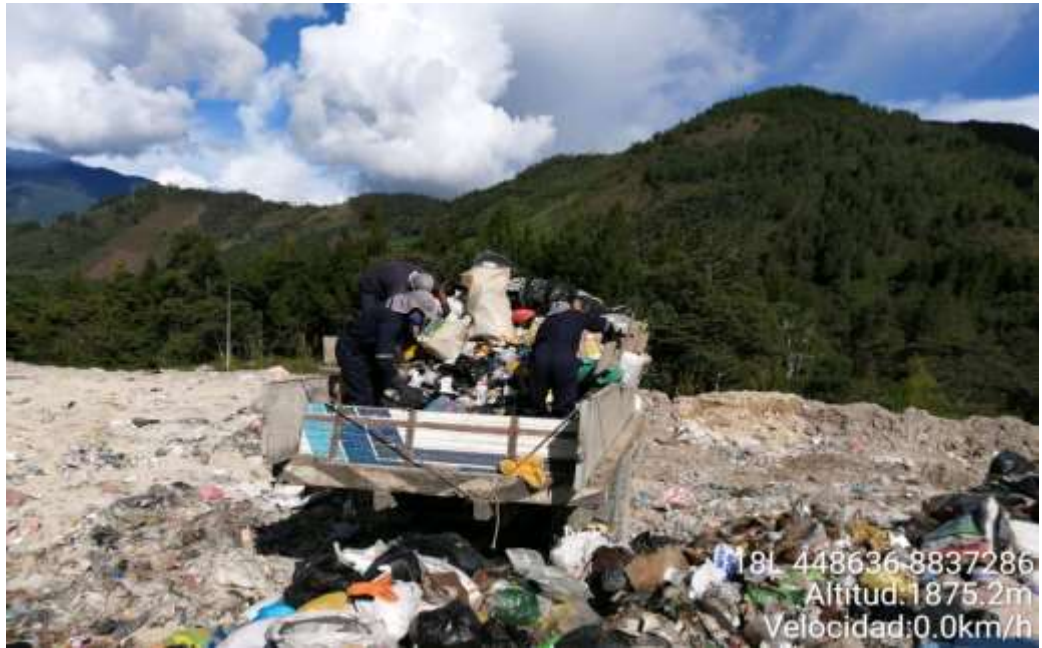
Foto N°12: Descarga de residuos solidos en la terraza N°1, del relleno sanitario Oxapampa.
