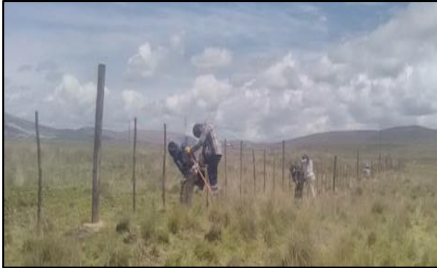
Figura 10. Colocación del Cerco perimétrico
