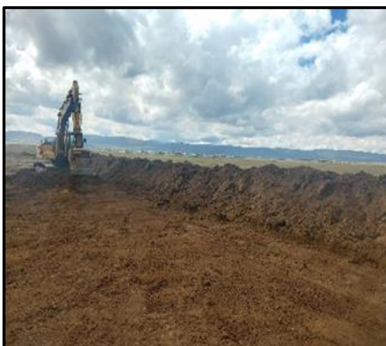
Figura 4. Extracción y acumulación de relaves coloniales
