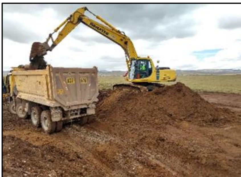
Figura 5. Transporte de relave previamente acumulado
