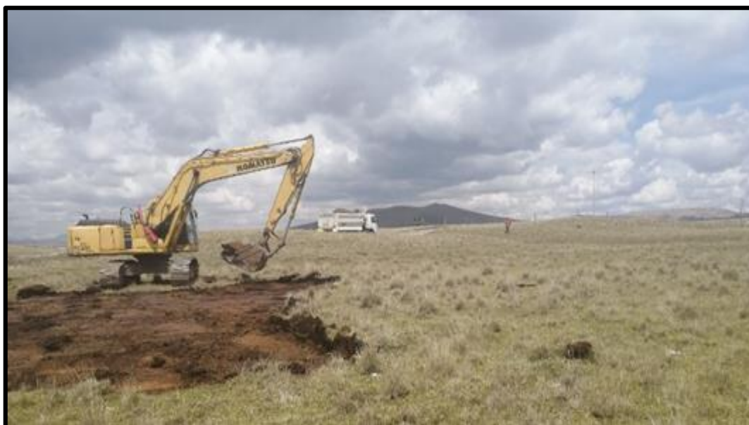
Figura 2. Retiro del pasivo ambiental
