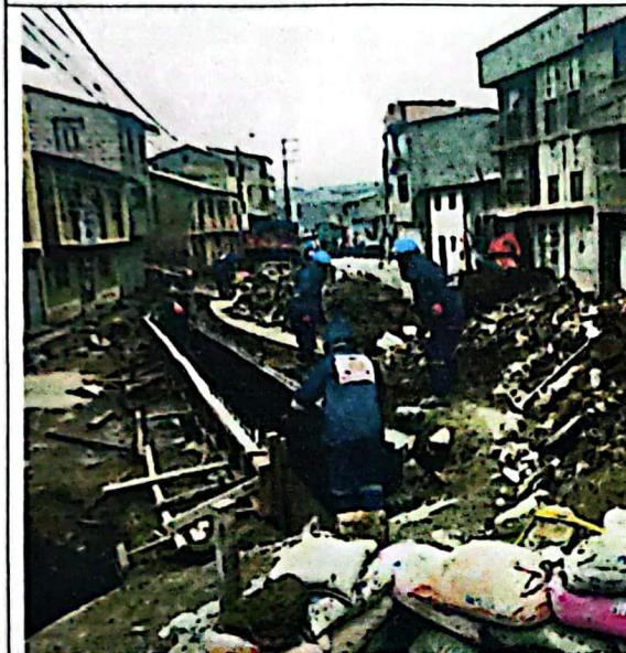
Desencofrado de canal de concreto
