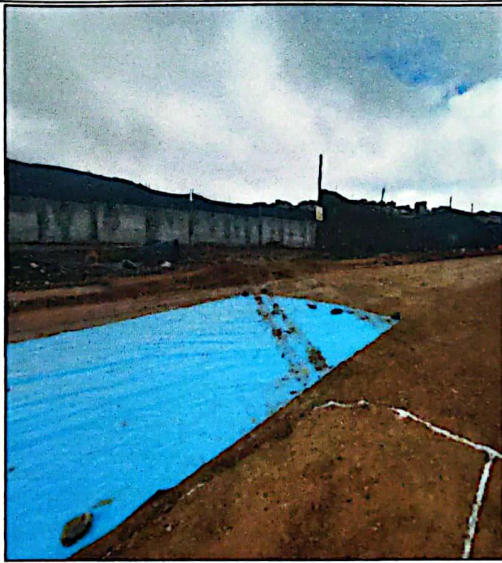
Trazo, nivel y replanteo
