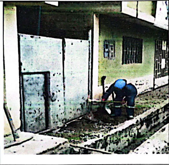
Nivelación y replanteo de veredas
