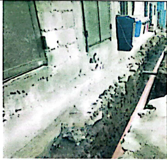
Instalación de tubos de desagüe
