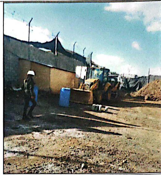
Almacen de obra
