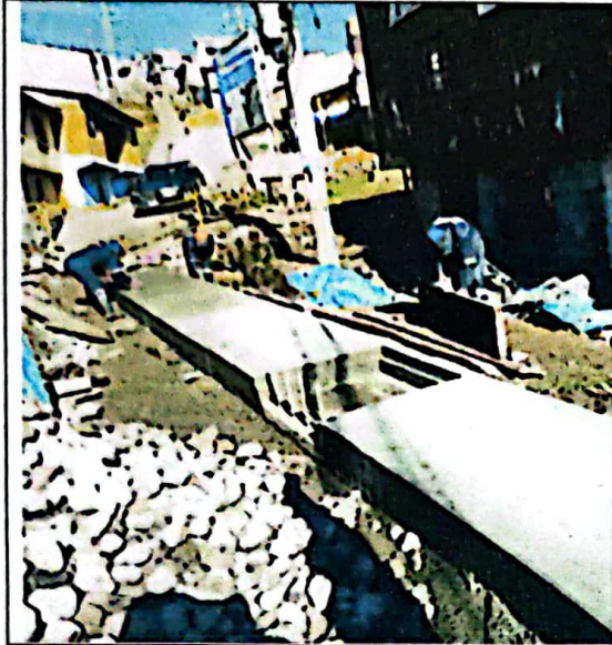
Vaciado de concreto f'c=210 en tapa de canal
