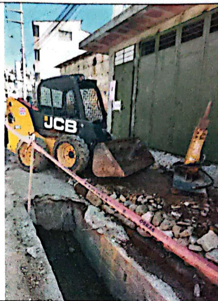
Movilización y desmovilización de equipos
