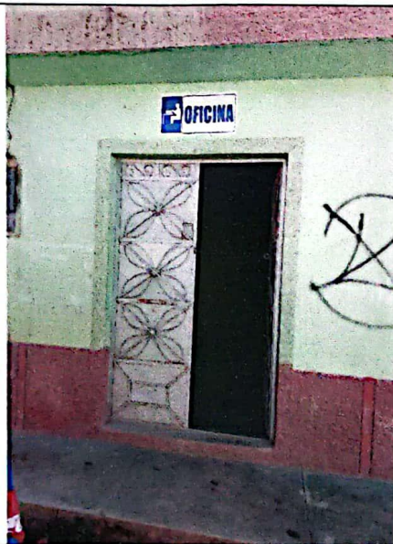
Oficina de obra
