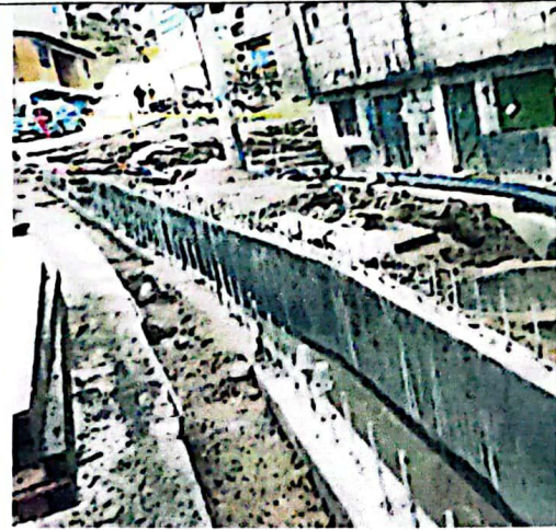
Tendido de Arrocera y Curado de Vereda
