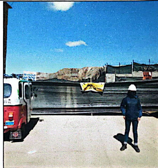
Cerco de obra
