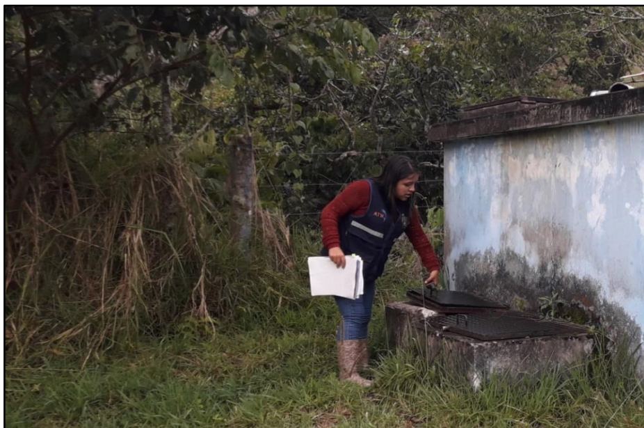
Anexo N° 2n. Verificación de los componentes de sistema de agua de la Junta Administradora de Servicios de Saneamiento del sector de Miraflores.
