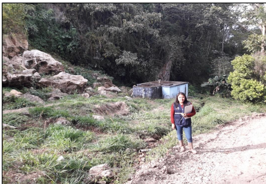
Anexo N° 2d. Infraestructura del reservorio N° 1 del sistema denominado Miraflores.
