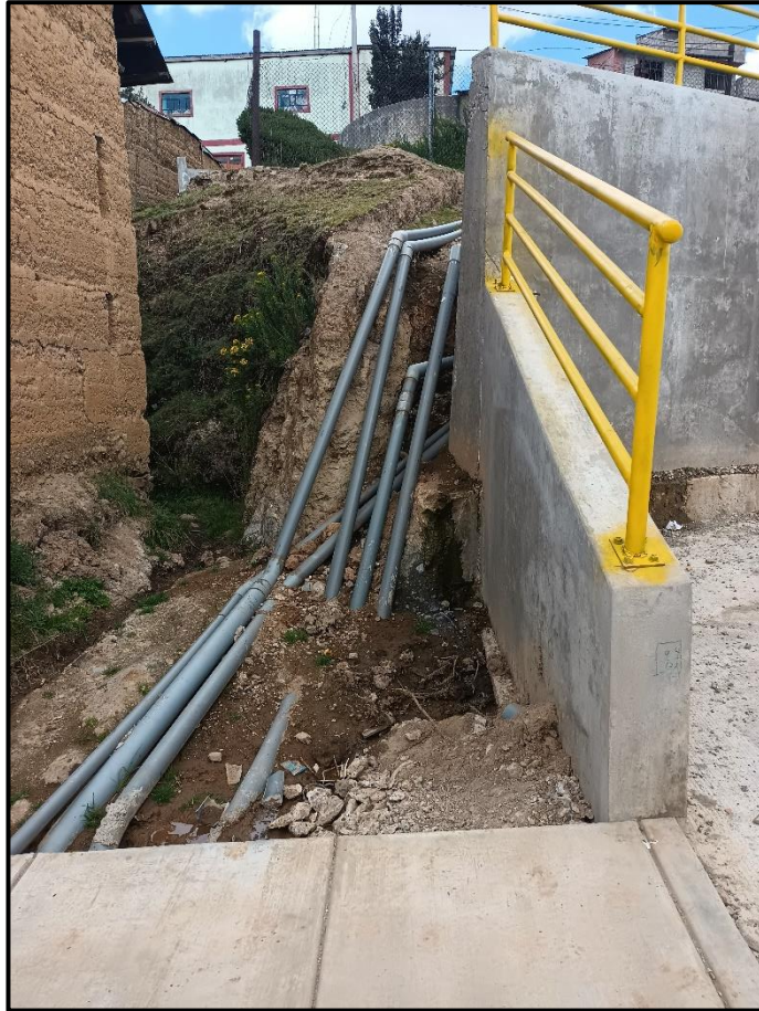
Imagen 4. Conexiones por sectores desde el reservorio general Uliachin
