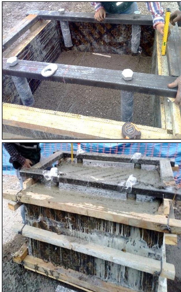
Figura N° 25 Encofrado, colocación de perfiles metálicos y vaciado de concreto en pedestales.
