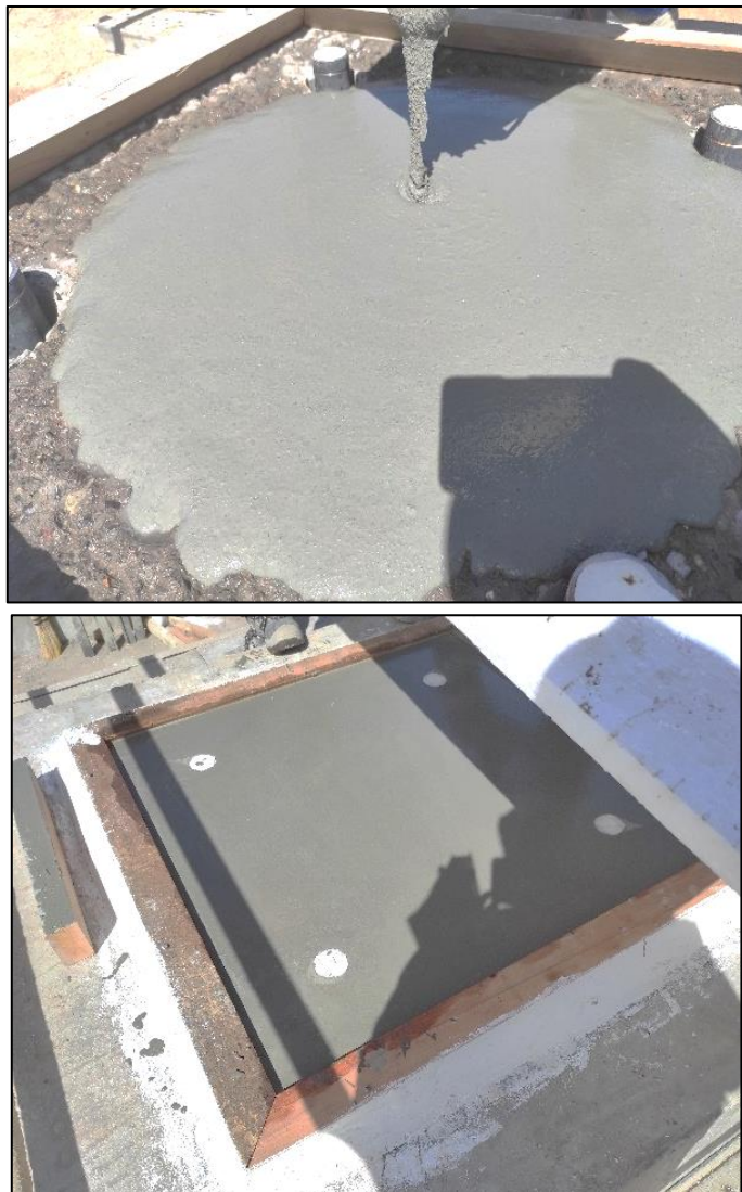
Figura N° 41 Colocación de la mezcla de mortero.
