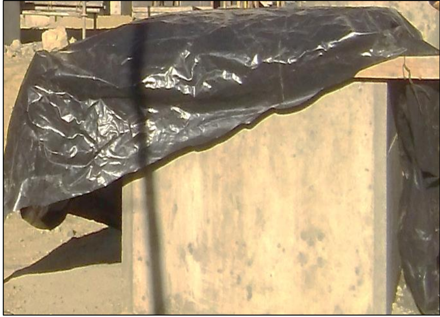
Figura N° 44 Protección del vaciado
