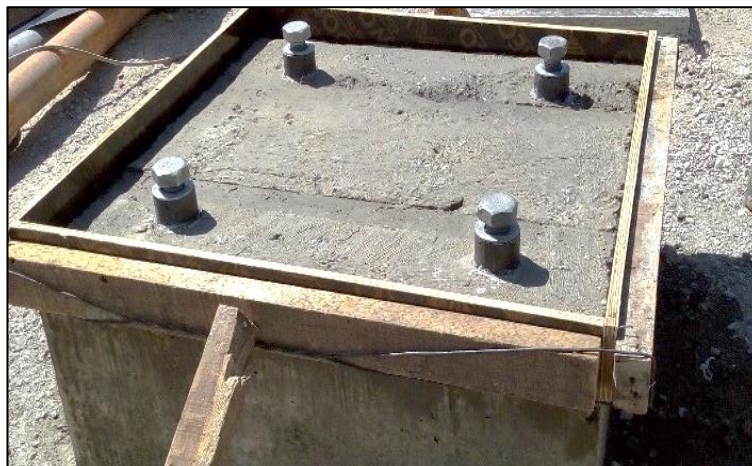
Figura N° 27 Construcción de pedestal terminado.
