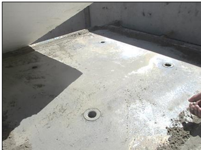
Figura N° 73 GE superficie acabada sin presencia de fisuras.
