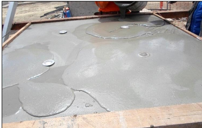
Figura N° 38 Mortero vaciado sin autonivelarse.
