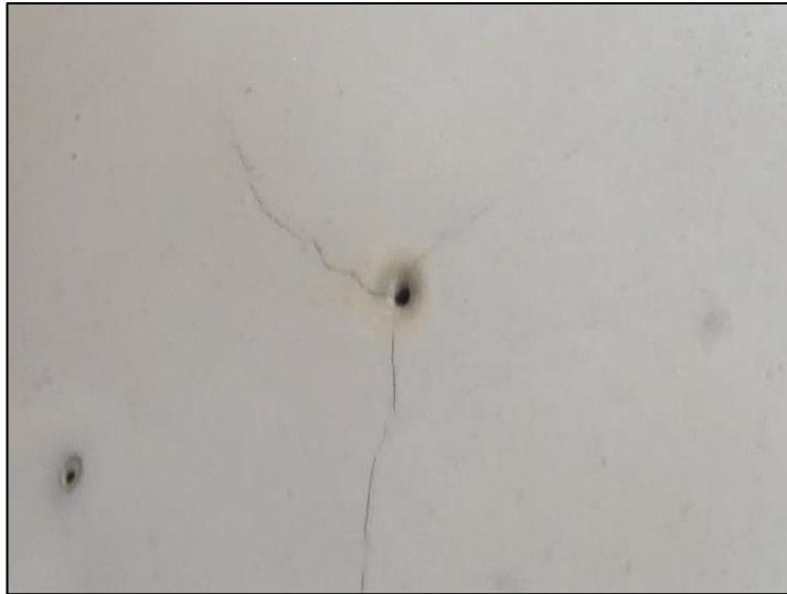
Figura N° 51 GC1 agujeros en el mortero durante el fraguado.
