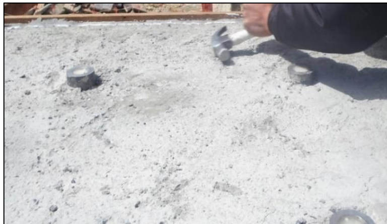
Figura N° 30 Verificación de partículas sueltas en la superficie de vaciado
