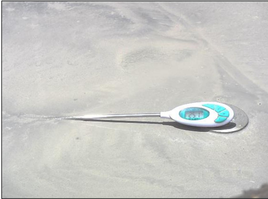
Foto 3 – GE medición de la temperatura en el mortero colocado.
