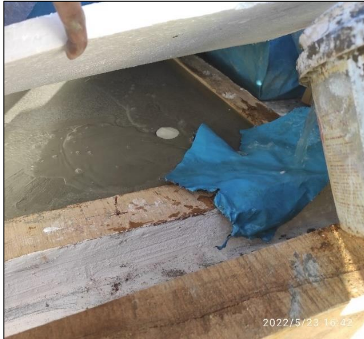
Figura N° 70 colocación de agua no directa
