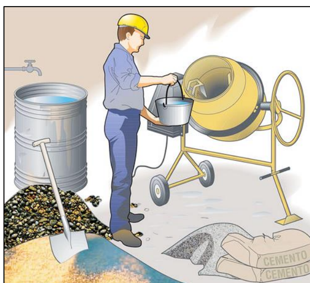
Figura N° 17 Mezclado de Concreto.
