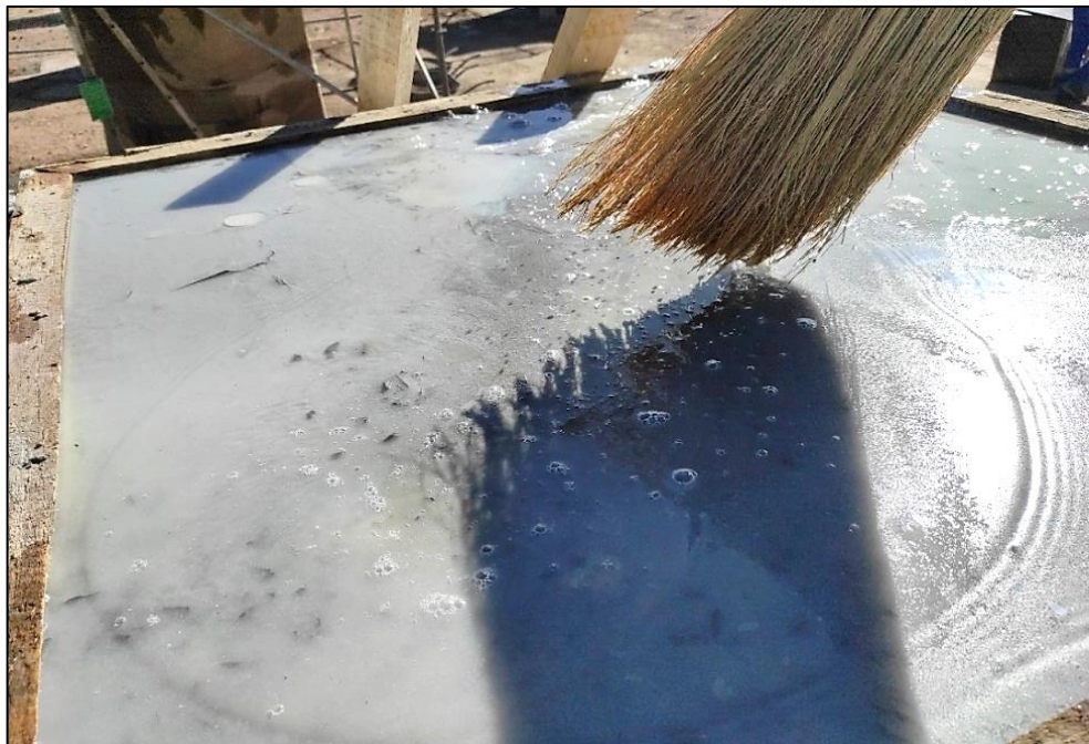
Foto 14 – GE retiro de agua de curado para evaluación de fisuras
