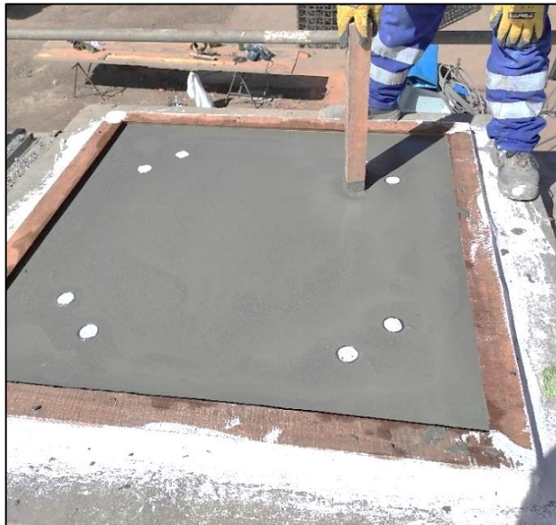
Figura N° 66 GE compactación de la superficie.
