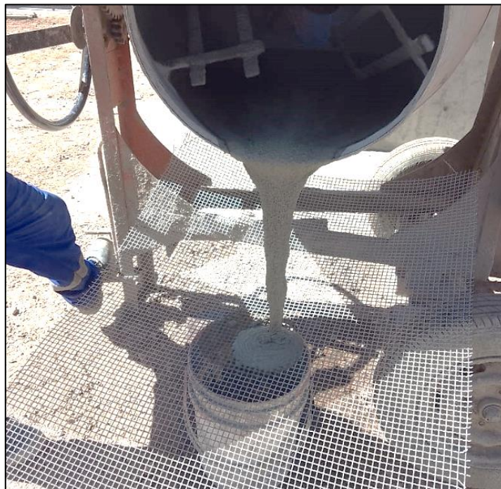
Figura N° 65 GE vertimiento de mortero a través de zaranda.
