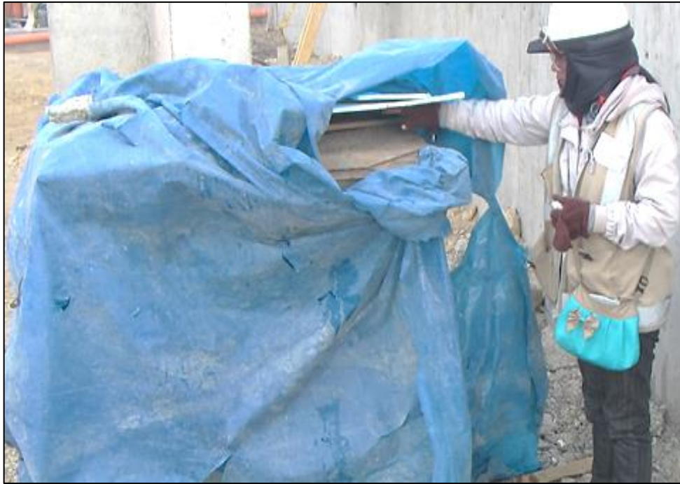
Foto 11 – GE método de protección y curado.
