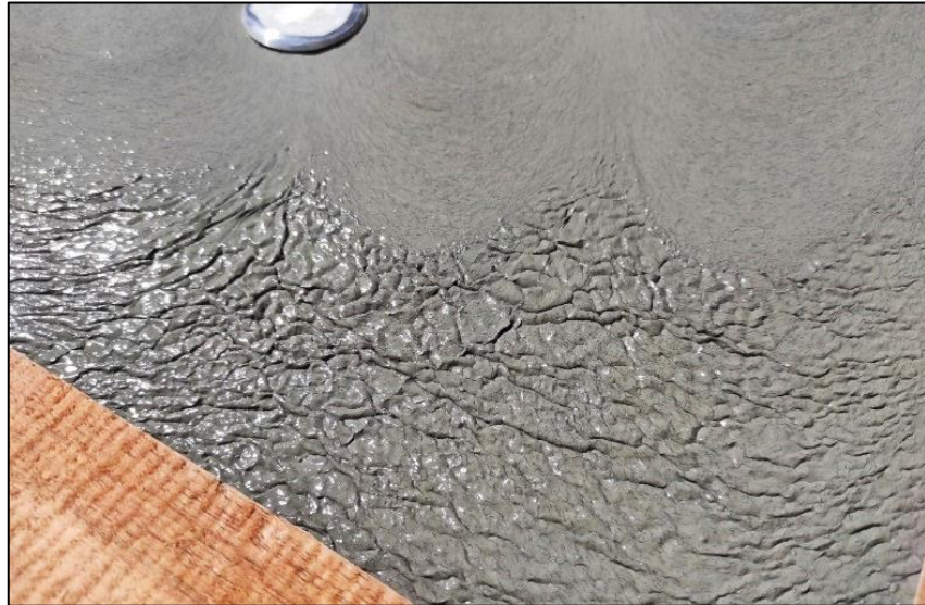
Figura N° 42 Película superficial de vaciado
