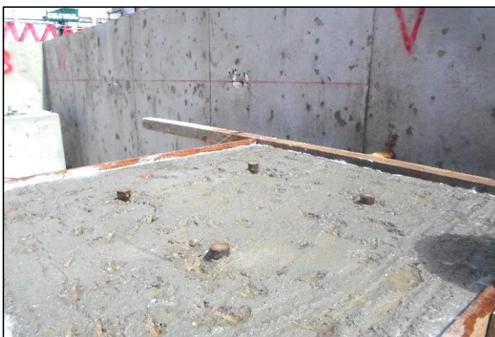
Figura N° 16 Preparación del lugar de colocación.
