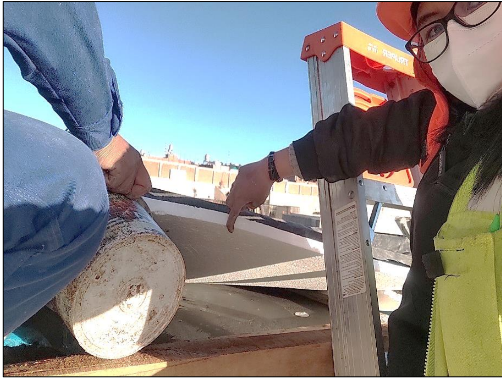
Foto 9 – GE verificación del fraguado inicial para la colocación del agua de curado
