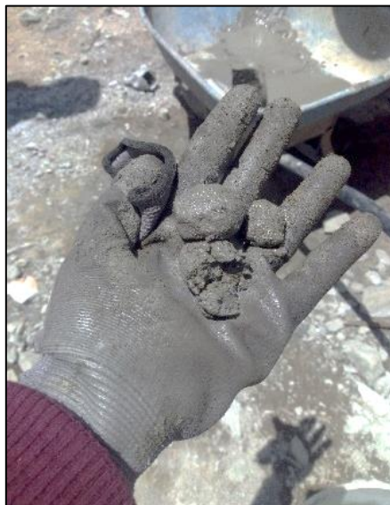
Figura N° 35 Mezcla de mortero no homogénea.
