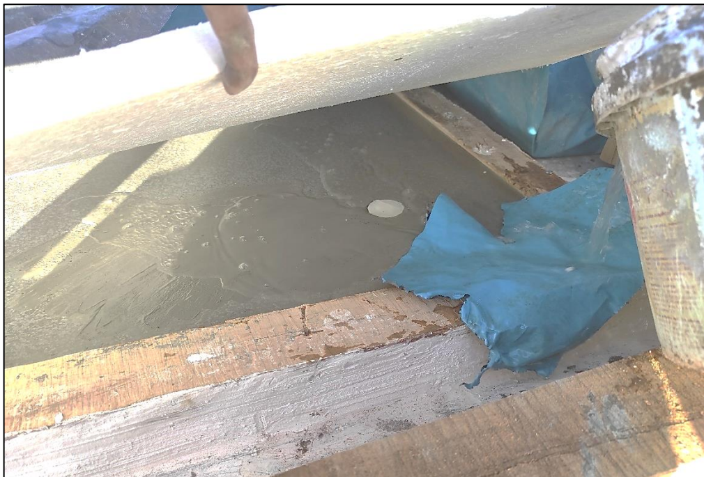
Foto 10 – GE Vertido indirecto de agua de curado a través de un plástico.
