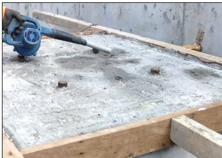
Figura N° 31 Limpieza de la superficie de vaciado
