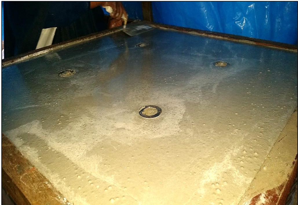
Foto 8 – GC2 Inspección visual para identificación del inicio de fraguado
