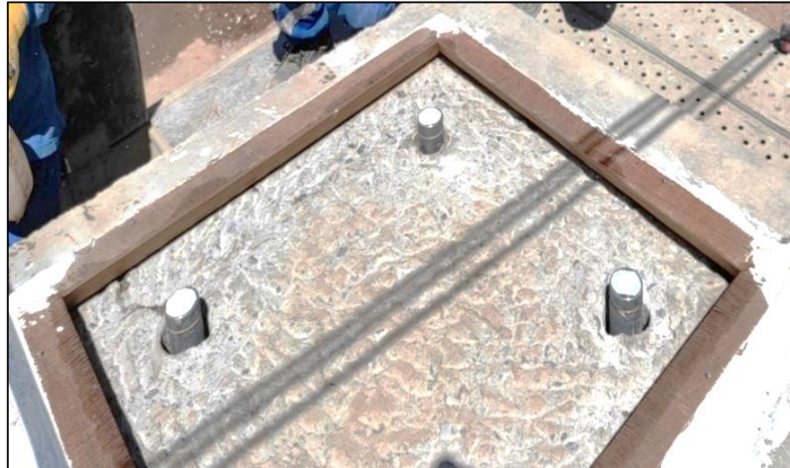
Figura N° 32 Encofrado del área a vaciar con mortero
