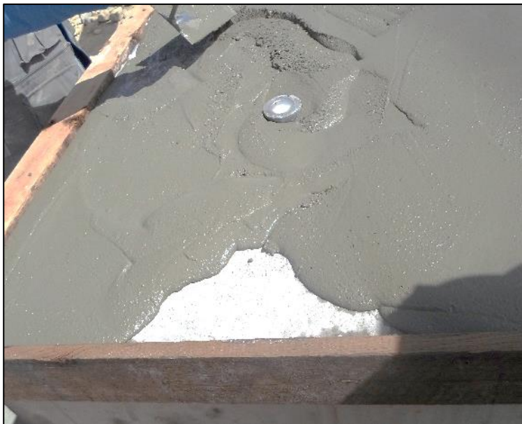
Figura N° 36 Inspección visual de las propiedades autocompactantes y autonivelantes.
