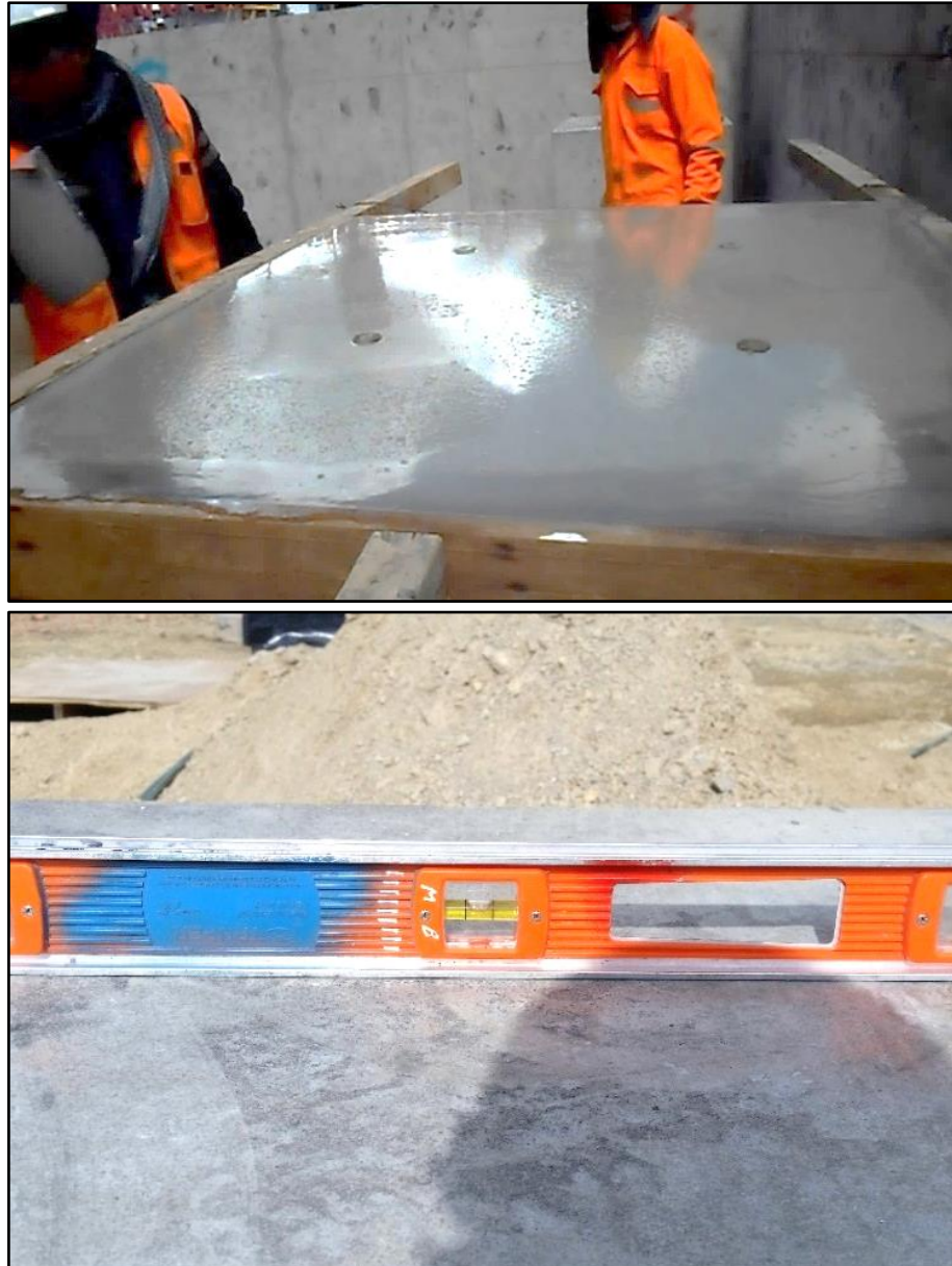
Figura N° 5 Característica Autonivelante del Mortero en estado fresco.
