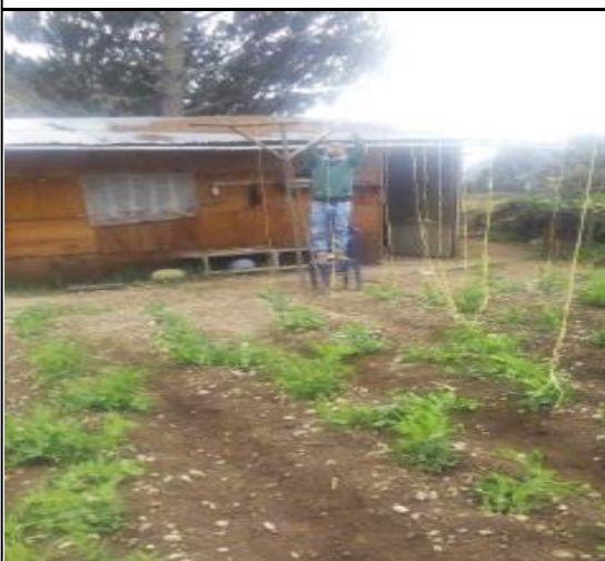
F-17. TENDIDO DE ALAMBRE
