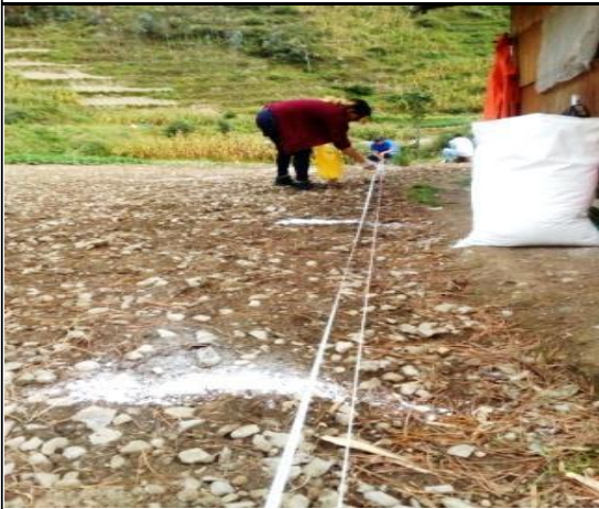
F-03.MARCADO DEL TERRENO CON CAL AGRICOLA
