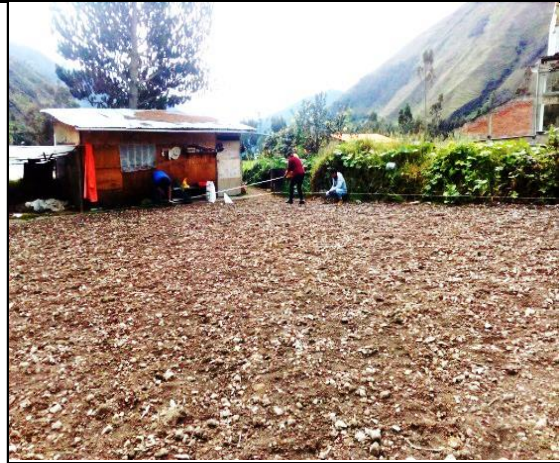
F-02. .MARCADO DEL TERRENO CON CAL AGRICOLA
