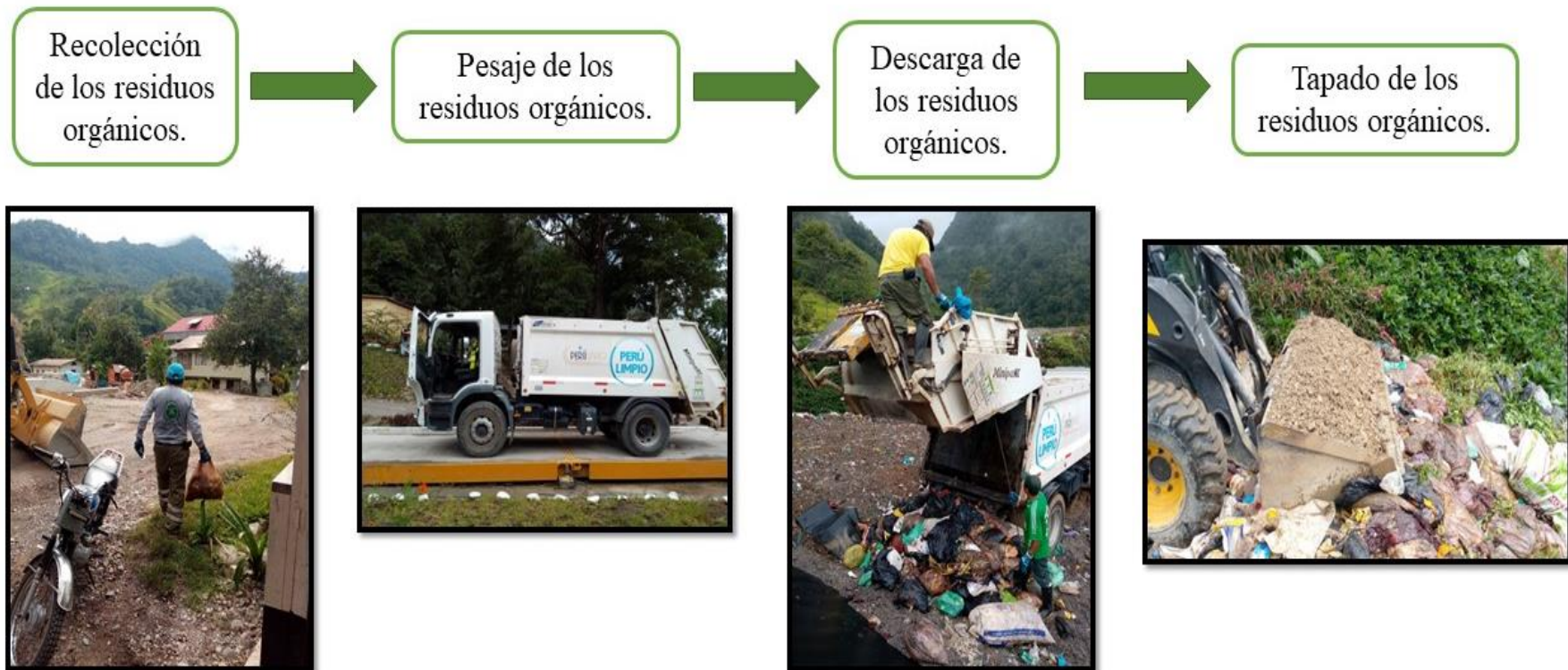
Fotografía 1. Flujo de manejo de los residuos orgánicos realizado por la Municipalidad distrital de Pozuzo.
