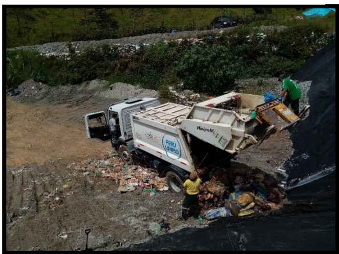
Fotografía 5. Disposición de residuos orgánicos en la terraza 1 del relleno sanitario.
