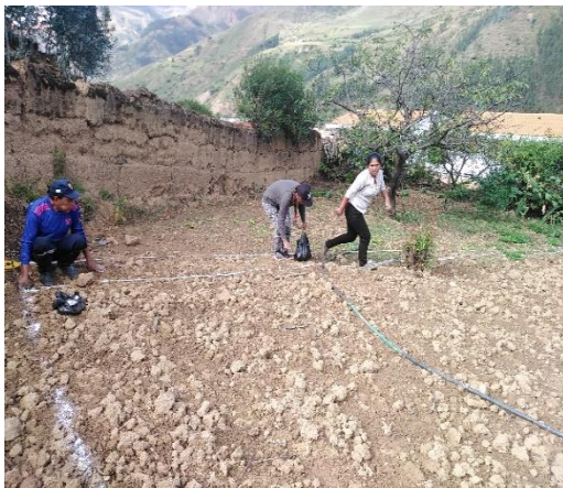
Fig 3 Preparación de terreno
