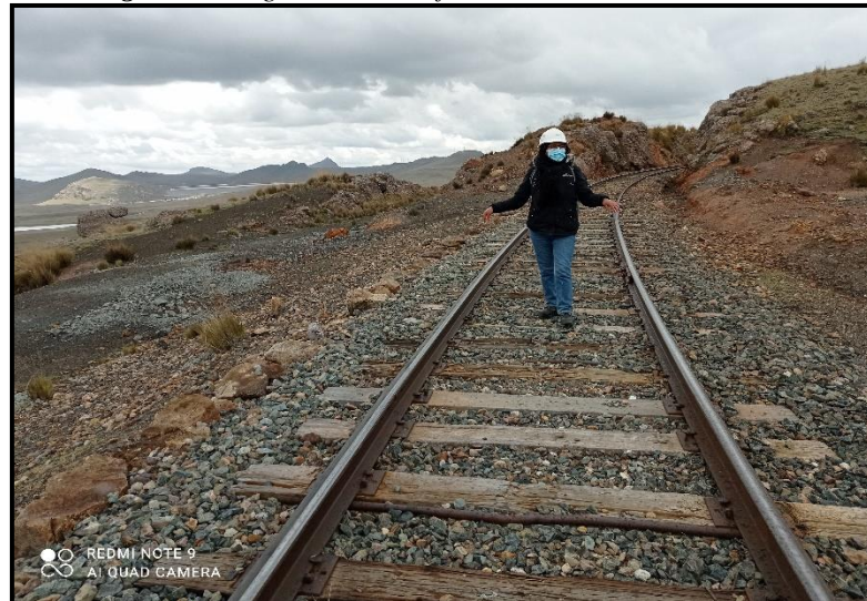
Figura 4. Imagen de la Vías férrea anclado en los durmientes
