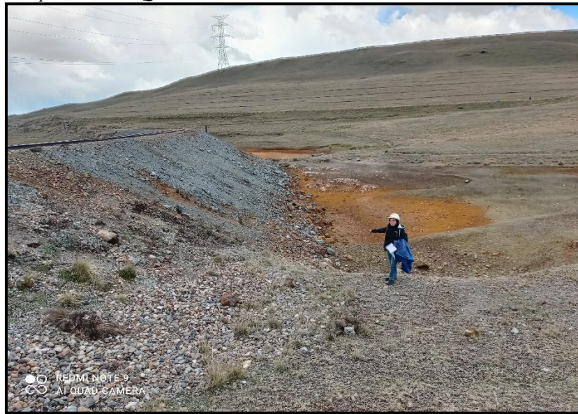
Figura 6. Imagen del talud formado con presencia de material piritoso en las alturas de la población de Quiulacocha
