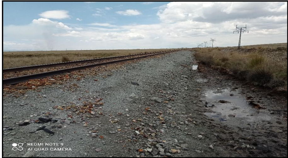
Figura 10. Imagen tomando medidas de material piritoso acumulado al entorno de la vía férrea
