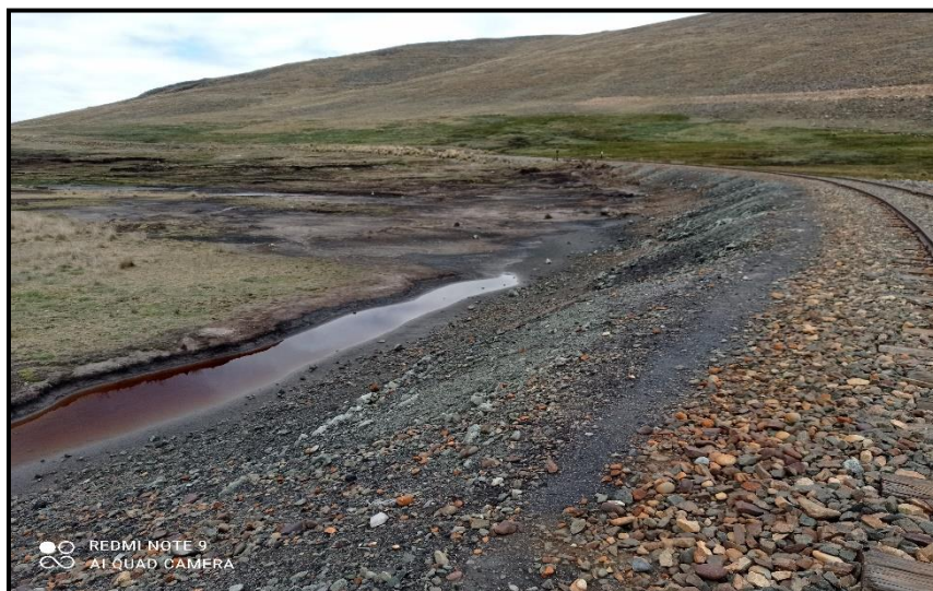
Figura 14. Imagen del talud formado con presencia de material piritoso en la zona de Unish
