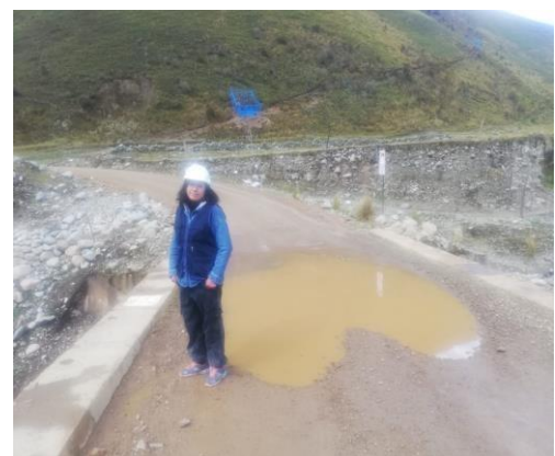
En la progresiva 3+000 aparecen Baches de gravedad 3.
