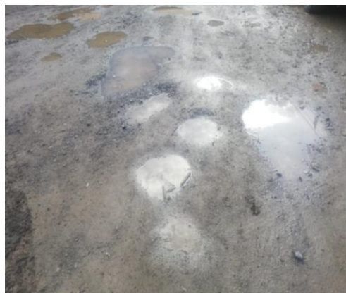
En la progresiva 3+000 aparecen Baches de gravedad 3.
