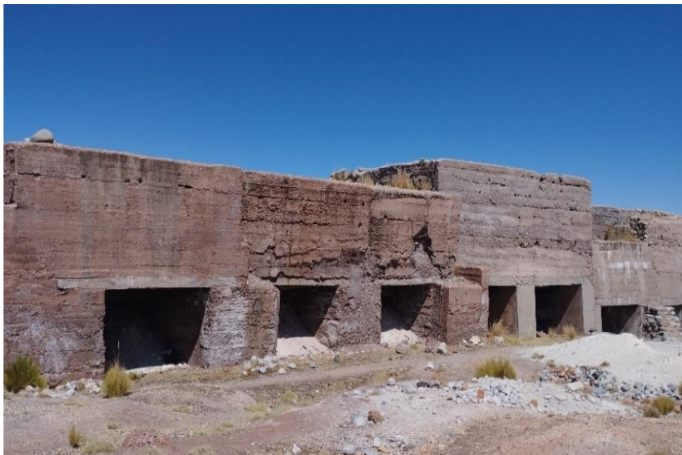
Recreación de las tareas de carga de un horno de cal
