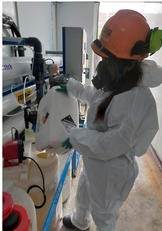
Ilustración 22.- Preparación de productos químicos necesarios en la PTAP -ósmosis inversa
