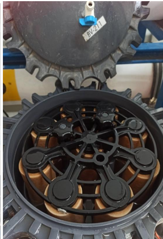
Ilustración 29.- Cambio de filtros micrómicos en los filtros pulidores- planta ósmosis inversa
