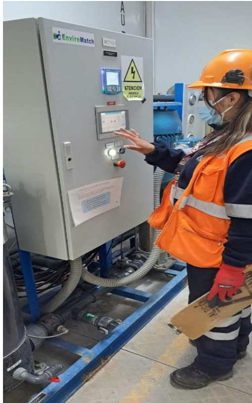
Ilustración 28.- Manipulación de Tableros de Control para la Operación de la Planta de Ósmosis Inversa.
