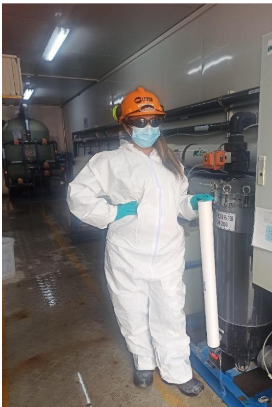
Ilustración 29.- Cambio de filtros micrómicos en los filtros pulidores- planta ósmosis inversa
