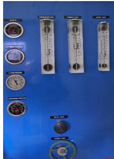
Ilustración 14.- Rotámetros del sistema del proceso de la Ósmosis Inversa
