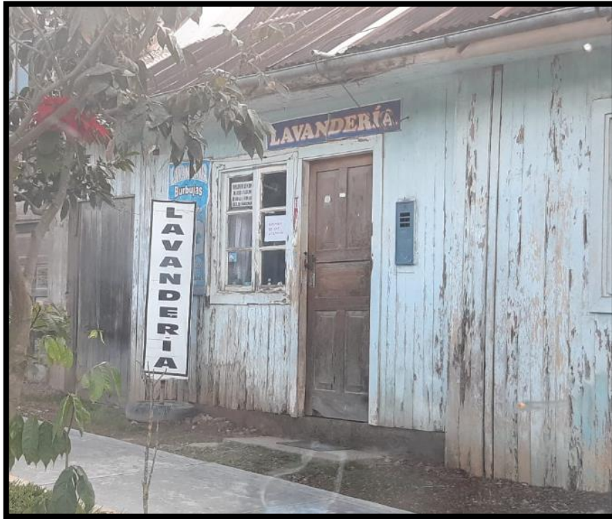
Foto C1. Centros de lavandería, instalada en viviendas
