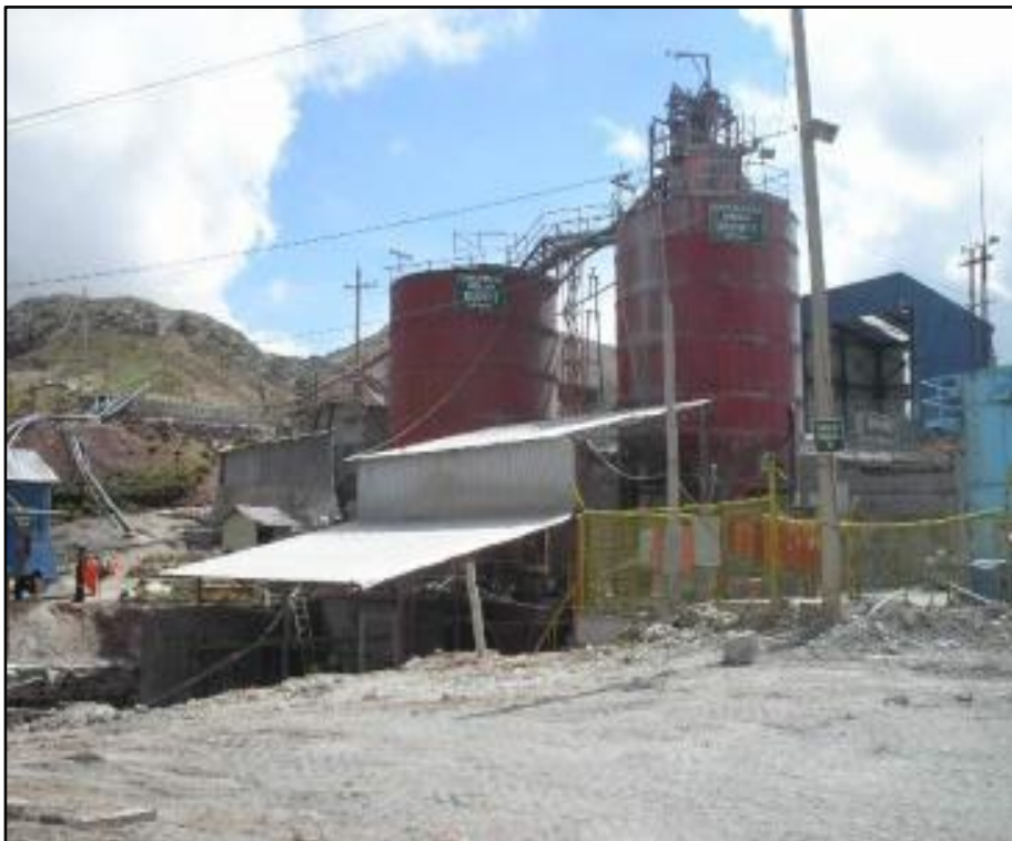
Figura 8 Planta de Relleno Hidráulico de la Mina Animón
